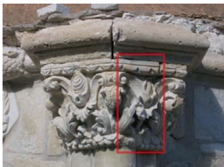
Εικ. 19. Συμπλήρωση κιονοκράνου με νέο ανάγλυφο τμήμα.
