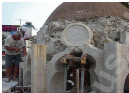
Εικ. 21. Αναδόμηση πλευράς της Κρήνης.
