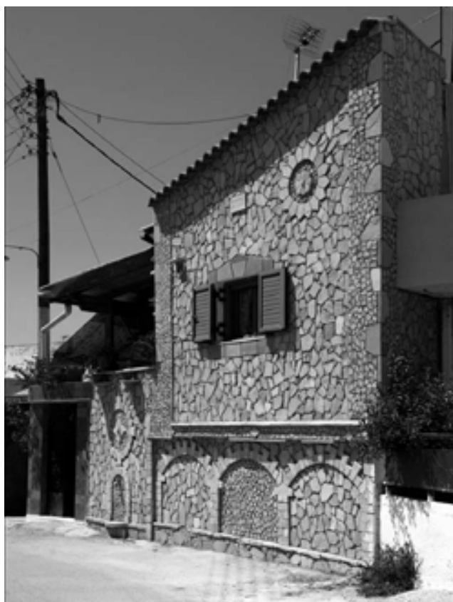
Φωτ. 20. Οικοδομή με λίθινη επένδυση στη Βαγιωνιά.
