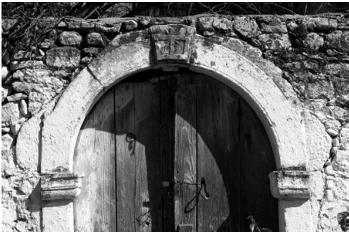
Φωτ. 16. Τοξωτό θύρωμα στη Γέργερη.
