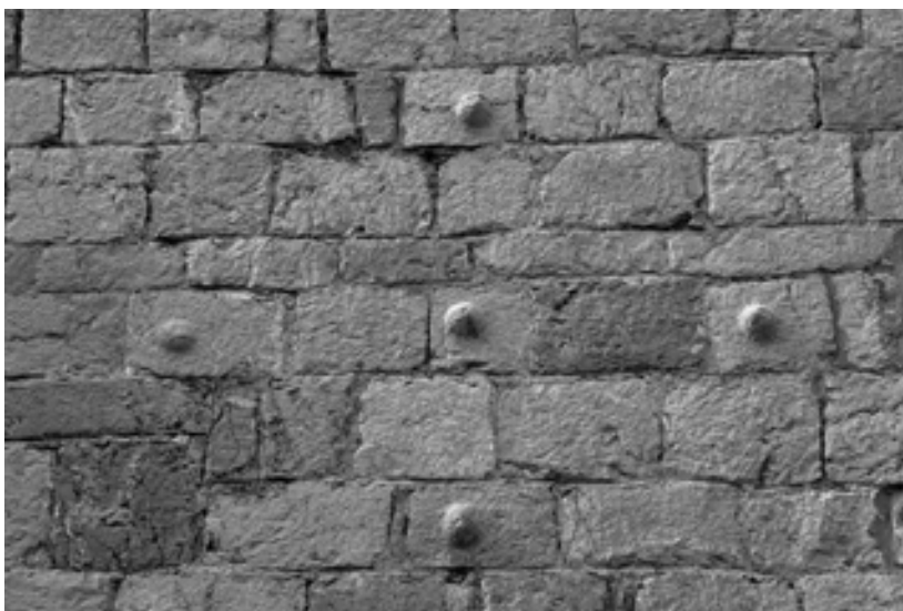
Εικ. 3. Ψευδοϊσοδομικό σύστημα (καθεδρικός ναός Στεμνίτσας Αρκαδίας).
