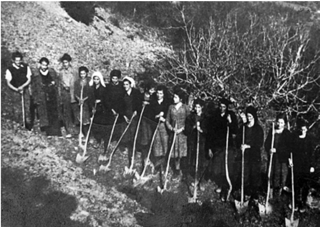
28. Η διάνοιξη του δρόμου στη Χώσεψη.
