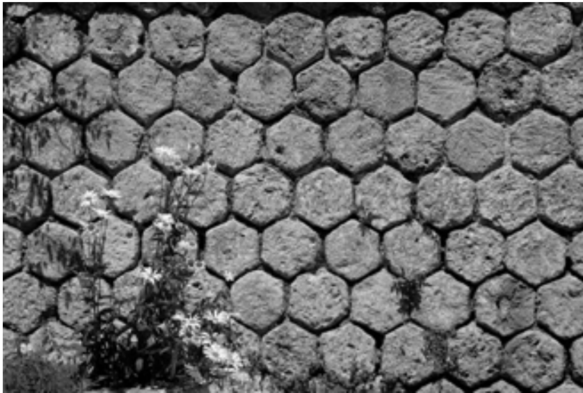
Εικ. 4. Πολυγωνικό σύστημα - εξαγωνικό (Αγία Βαρβάρα Καλαβρύτων).
