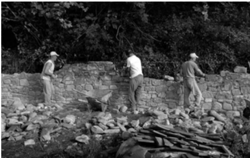
Εικ. 2. Αργολιθοδομή (Βούρμπιανη Δήμου Μαστοροχωρίων, Ιωάννινα).
