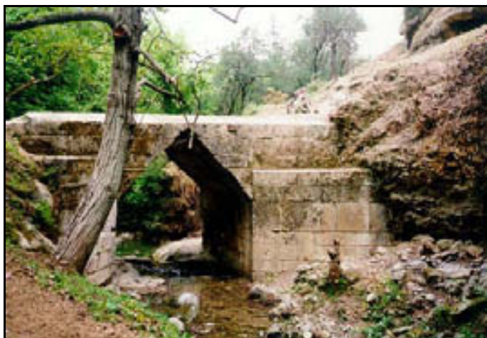
Εικόνα 18: Η Βόρεια γέφυρα της Ελεύθερας
