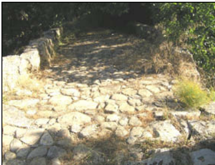
Εικόνα 17: Το κατάστρωμα της γέφυρας του Φιλίππου
