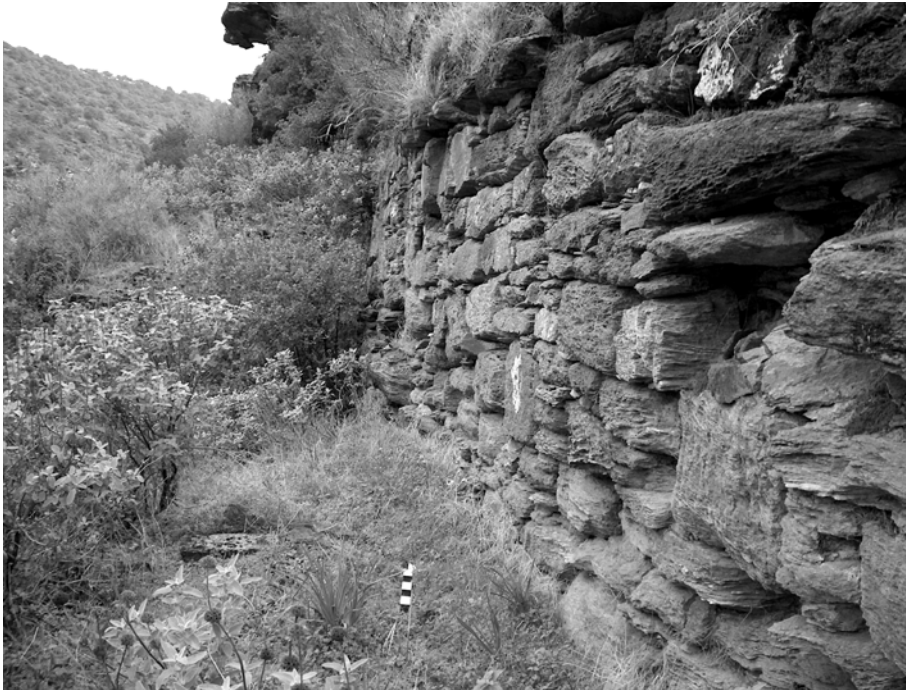
Ανάλημμα στη δυτική πλαγιά της Θέσης ΚΤ020, Λουτριανή.
