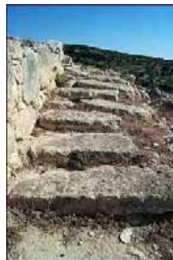
Εικ. 2.4.5. Το κλιμακοστάσιο που οδηγεί στο ανώτερο άνδρηρο
