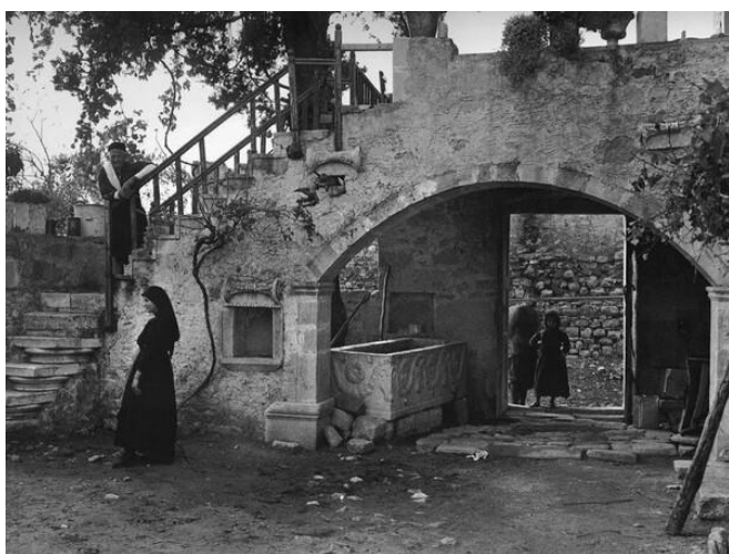
Εικόνα 30: Κρήτη: προαύλιο σπιτιού, 1919. Frederic Boissonas (1858-1946)
