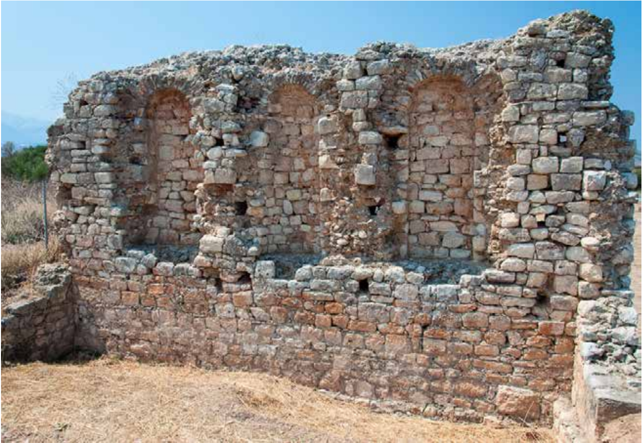
Εικ. 82 Απτέρα, τοίχος ρωμαϊκού οικοδομήματος με κόγχες για τοποθέτηση αγαλμάτων. (Copyright Commons permit)
