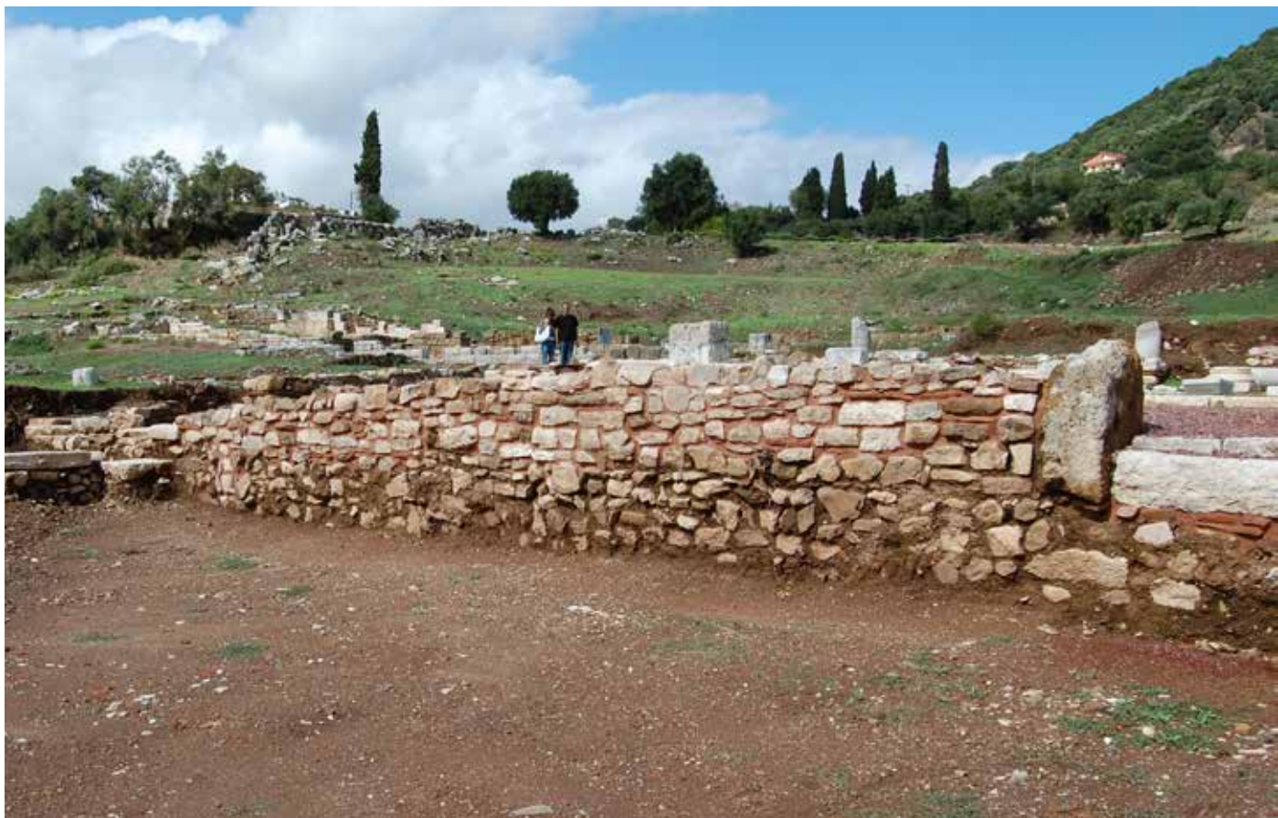
Εικ. 259 Εξωτερική όψη του νότιου τοίχου της βασιλικής με το θεμέλιό του. Άποψη από Ν. (αρχείο ΕΜΑΣ)
