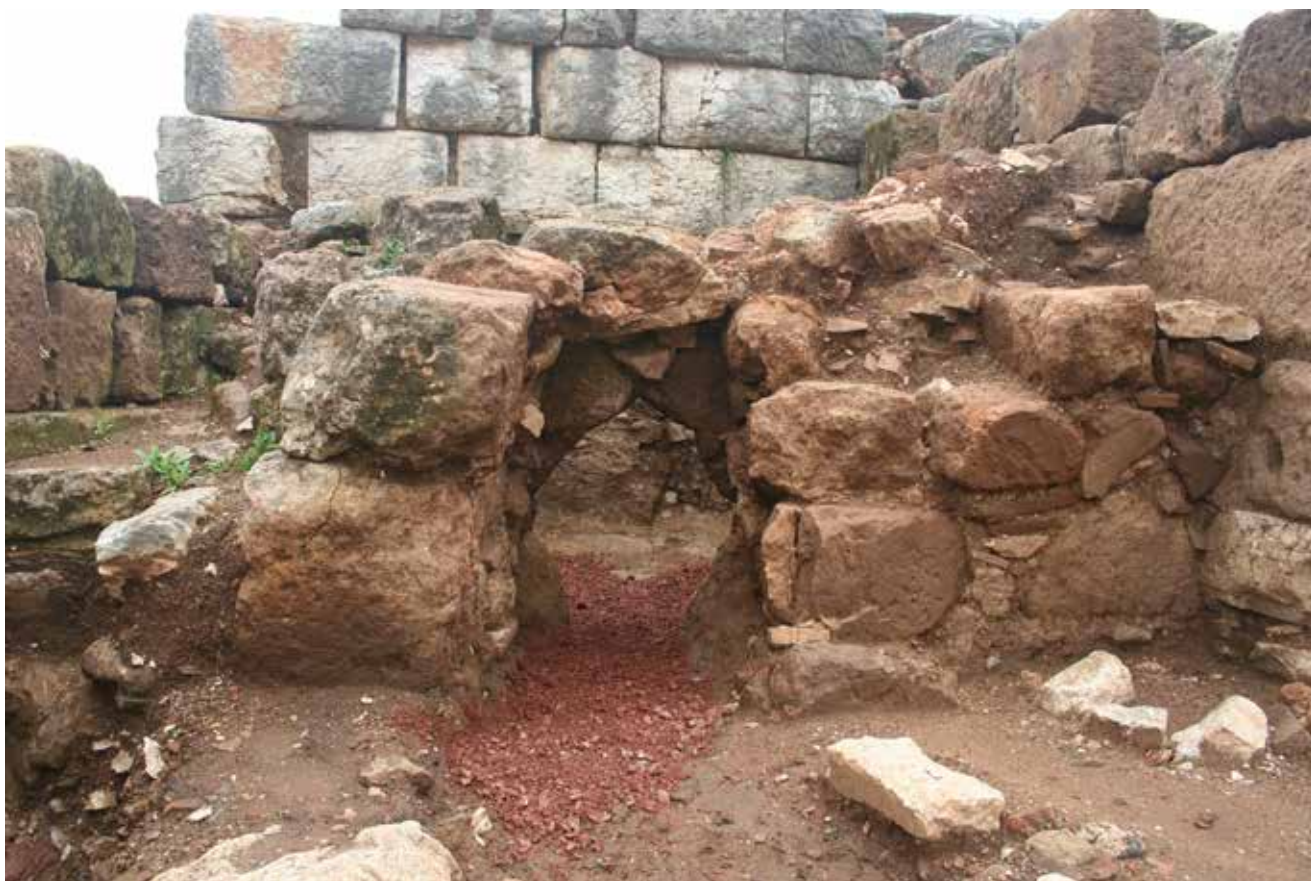
Εικ. 222 Ασβεστοκάμινο στου ανατολικό ανάλημμα του θεάτρου, λεπτομέρεια του στομίου πλήρωσης του φούρνου, άποψη από Α (αρχείο ΕΜΑΣ)
