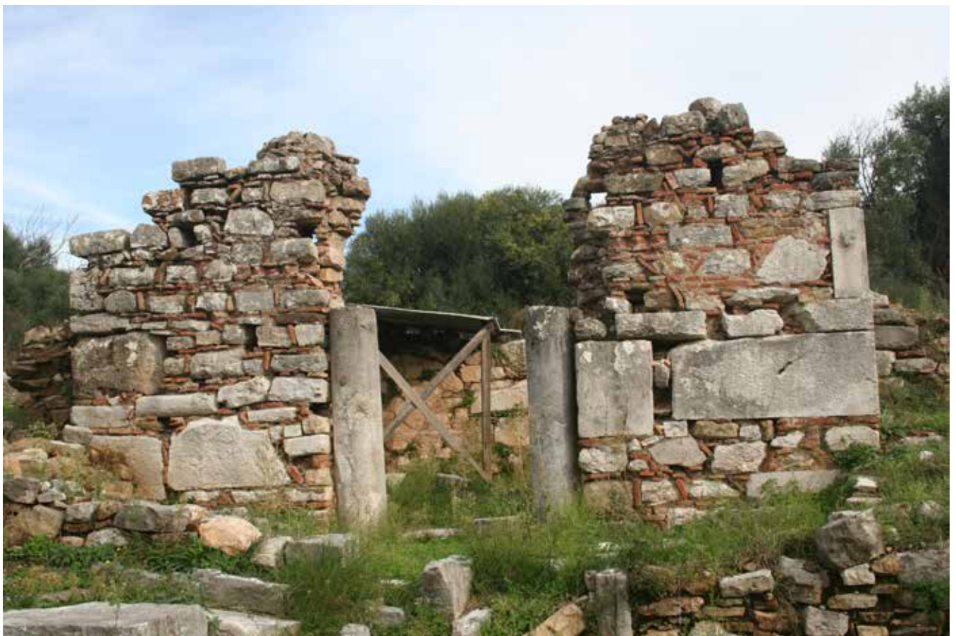
Εικ. 111 Βασιλική του Ασκληπιείου, όψη του δυτικού τοίχου (αρχείο ΕΜΑΣ)
