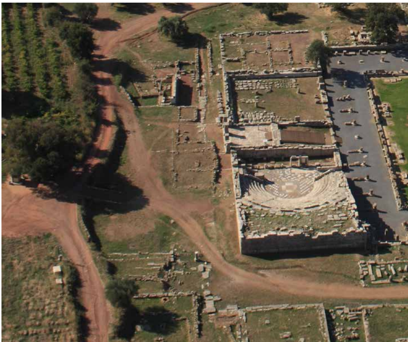
Εικ. 85 Η Ανατολική οδός μπροστά από το Ασκληπιείο με τα κατάλοιπα των οικιών, αεροφωτογραφία από Β, 2014. (αρχείο ΕΜΑΣ)
