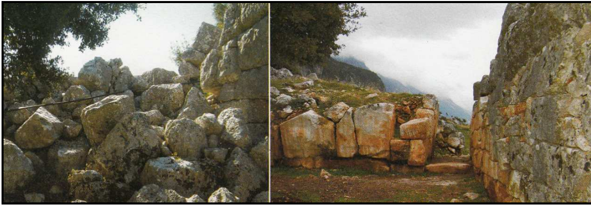
65. Ελέα. Η Μικρή Πύλη 2 πριν (αριστερά) και μετά (δεξιά) τις εργασίες καθαρισμού (Ρήγιнос – Λάζαρη 2007, 35)
