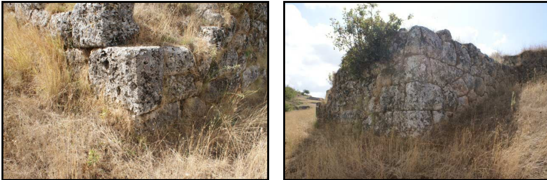
23. Επιμελής ταινιωτή λάξευση στις γωνίες του Πύργου 2.
