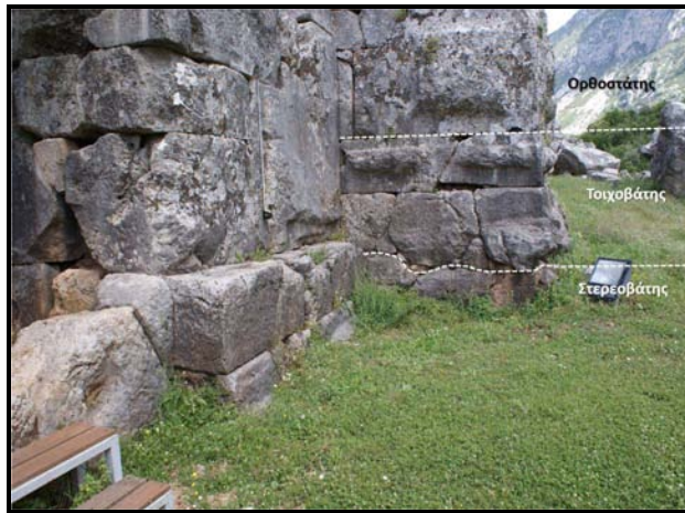
55. Λεπτομέρεια του τείχους της Ελέας στην περιοχή της Πύλης 1.
