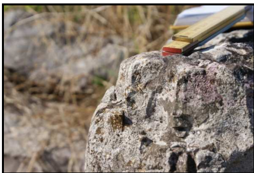
97. Γένεση ταινιωτής λάξευσης στον κατώτερο, μοναδικό σωζόμενο γωνιόλιθο της Θλάσης γ
