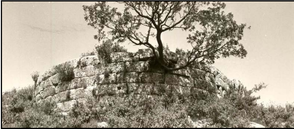
19. Πύργος 10. Ισόδομο τραπεζιόσχημο σύστημα τοιχοποιίας (Αρχειο ΛΒ΄ Εφορείας Προϊστορικών & Κλασικών Αρχαιοτήτων)
