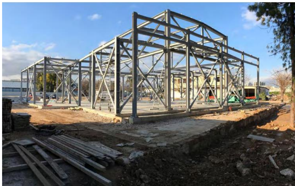
Εικόνα 2-5. Ο μεταλλικός σκελετός του Ισλαμικού Τεμένους στο Βοτανικό. Πηγή: Παπαδόπουλος, 2017
