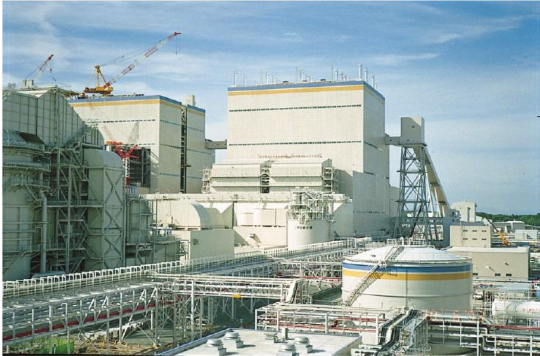
Εικόνα 3. Εξωτερική άποψη του DeNO x Plant του Εργοστασίου Παραγωγής Ενέργειας Shinchi Power Station Unit No. 1 της Soma Kyodo Power Co., Ltd. Απεικονίζονται δύο DeNO x αντιδραστήρες εμπρός και πίσω. 21β
