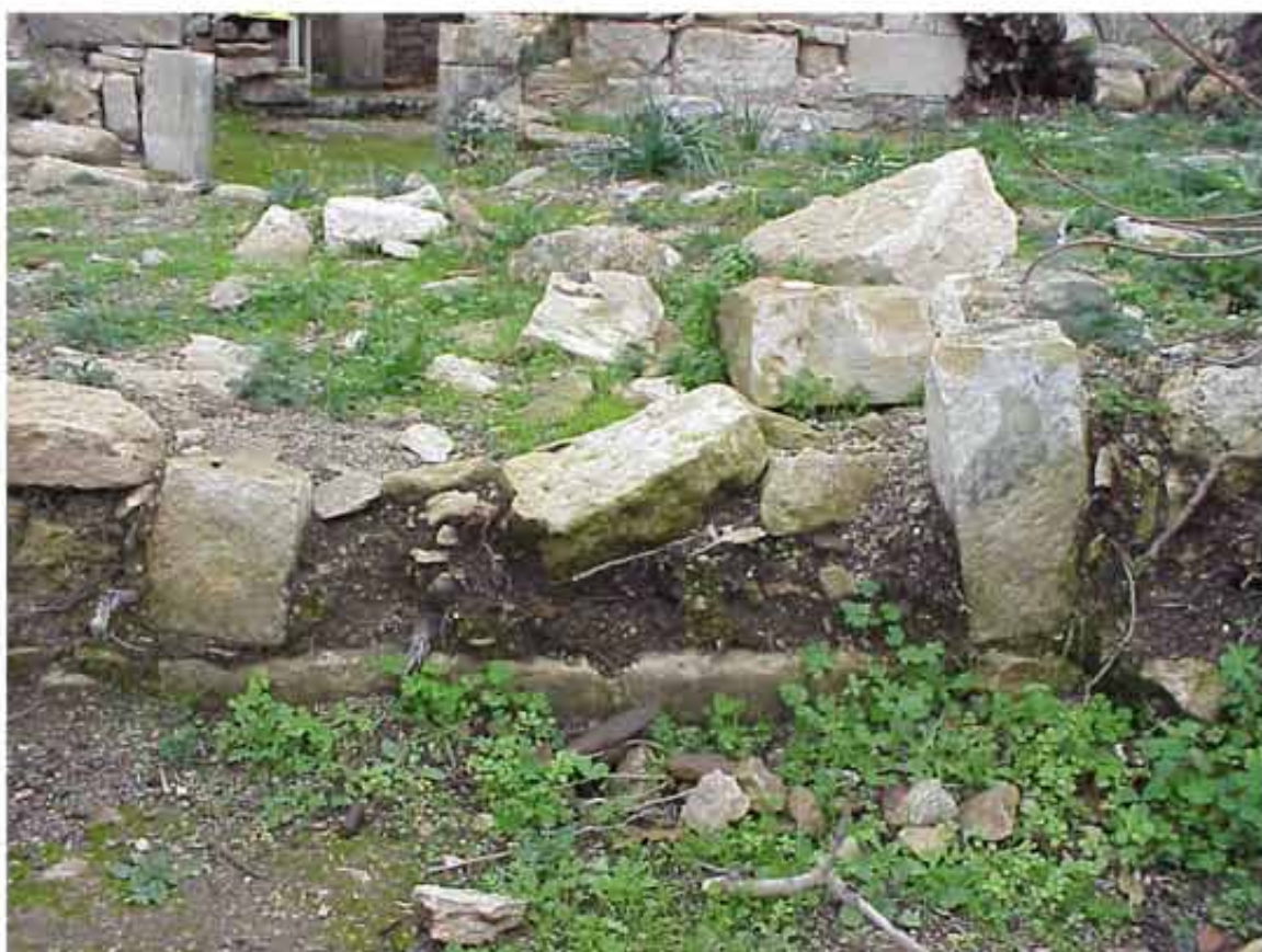
Εικόνα 53: Αγία Άννα Ελεύθερνας Μυλοποτάμου, το άνοιγμα της θύρας στον δυτικό εξωτερικό τοίχο
