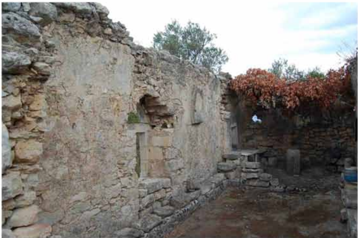
Εικόνα 51: Αγία Άννα Ελεύθερνας Μυλοποτάμου, άποψη του εσωτερικού από ΝΔ
