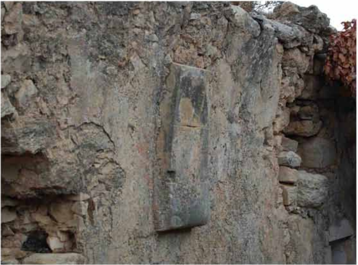
Εικόνα 35: Αγία Άννα Ελεύθερνας Μυλοποτάμου, η γένεση του κεντρικού σφενδονίου του νότιου τοίχου
