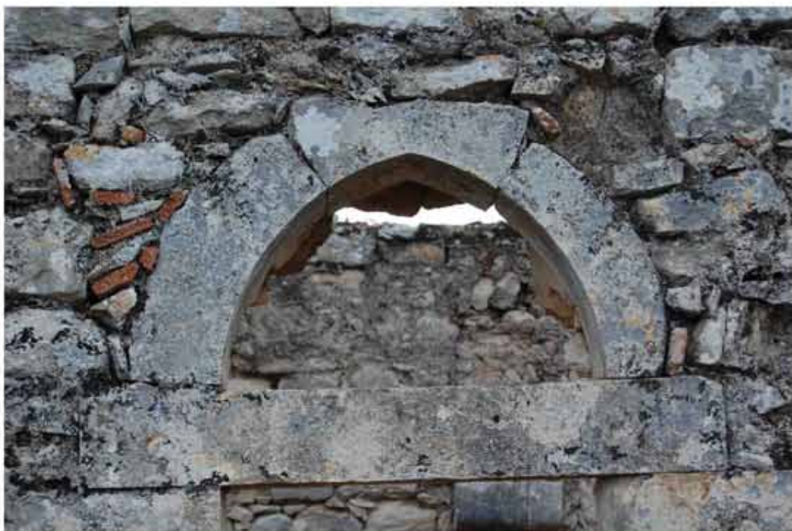
Εικόνα 52: Αγία Άννα Ελεύθερνας Μυλοποτάμου, το οξυκόρυφο τόξο πάνω από τη βόρεια είσοδο
