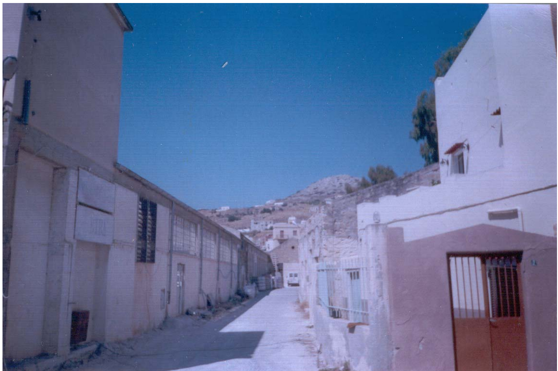
Άποψη του εργοστασίου Βαρδάκα στην Ερμούπολη
