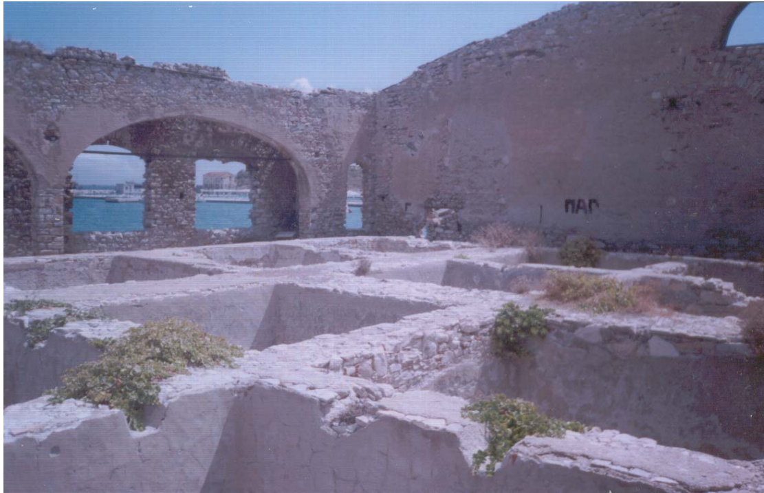
Εργοστάσιο υιών Λαδόπουλου: Τμήμα των Βαφείων. Οι δεξαμενές που φαίνονται στην φωτογραφία γέμιζαν με την κατάλληλη βαφή και μέσα σ' αυτές τοποθετούνταν τα υφάσματα
