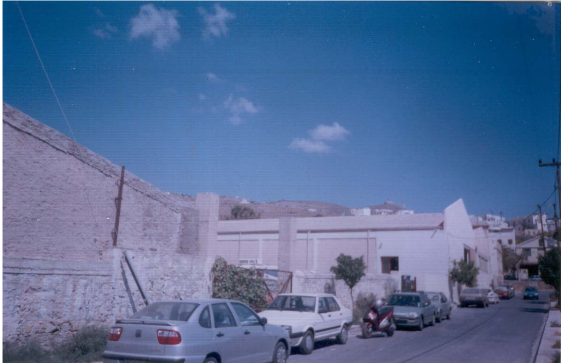
Άποψη του εργοστασίου Βαρδάκα στην Ερμούπολη
