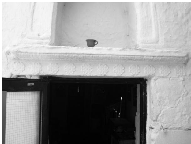
Εικόνα 183: Γείσο κόγχης άνω ορόφου του Χαρμυλείου, εντοιχισμένο στην εκκλησία του Σταυρού. Τσούλη 2013.
