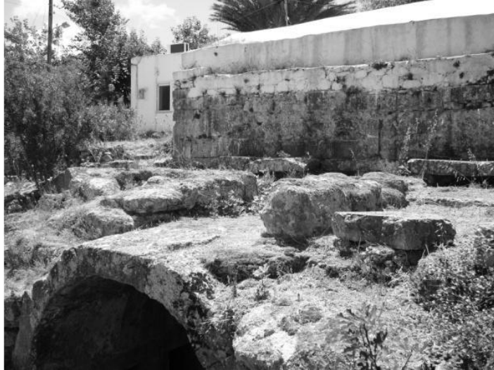
Εικόνα 174: Θεμελίωση ισογείου του Χαρμυλείου. Τσούλη 2013.
