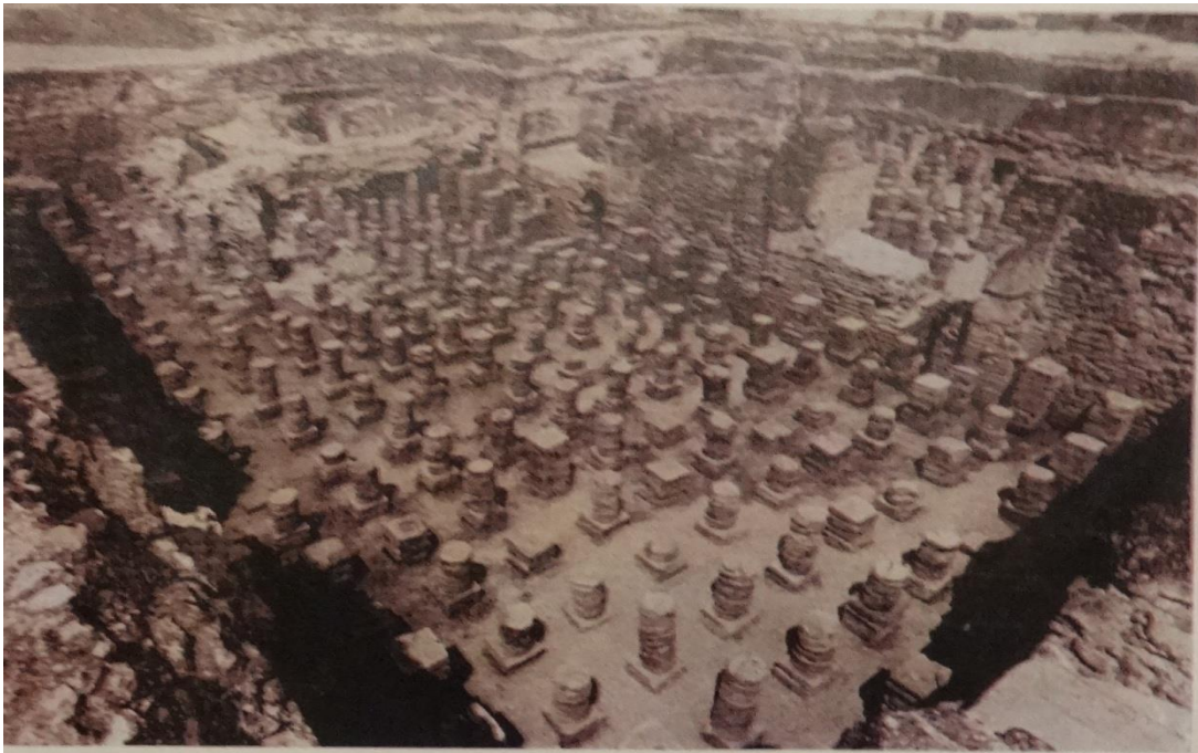
Εικ. 211: Οι πεσσίσκοι του υποκαύστου στο C2. (BCH 100 (1976), σελ. 748).
