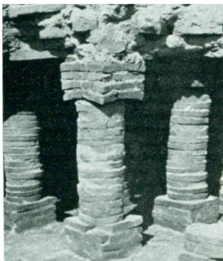
Εικ. 209: Τμήμα υποκαύστου από τους θερμούς χώρους του Λουτρού Α-1. (BCH 79 (1955), σελ. 327).
