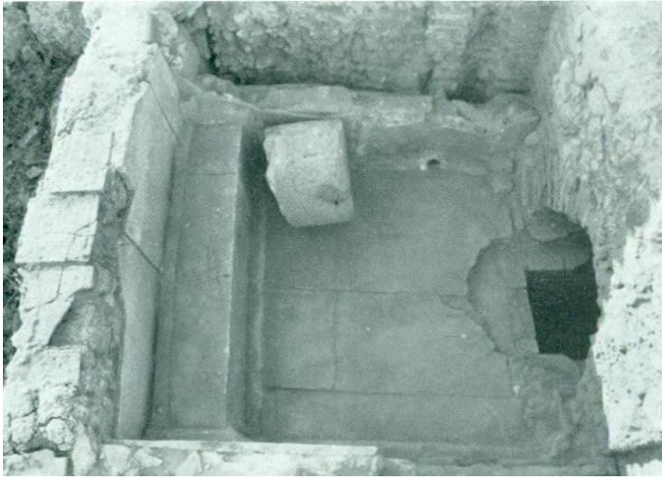
Εικ. 210: Η δεξαμενή θερμού ύδατος του χώρου C1, η οποία θερμαινόταν και με τη μέθοδο testudo alvei . (BCH 102 (1978), σελ. 774).
