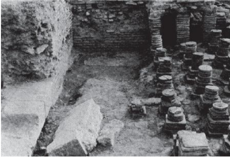
Εικ. 216: Υπόκαυστο στο terpidarium (T2) του Λουτρού Α-2. (BCH .108 (1984), σελ. 847).
