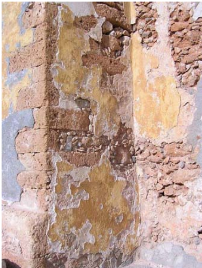
Εικ. X82β: Μονή Γουβερνέτου, Ακρωτήρι. Λεπτομέρεια της τοιχοποιίας.
