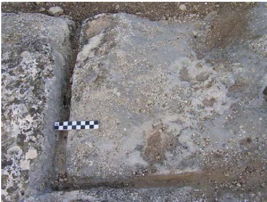
Εικ. P129α: Ελεύθερνα-Νησί, δυτικό άνδηρο. Λάξευση περιμετρικών αυλάκων γύρω από τον ογκόλιθο.
