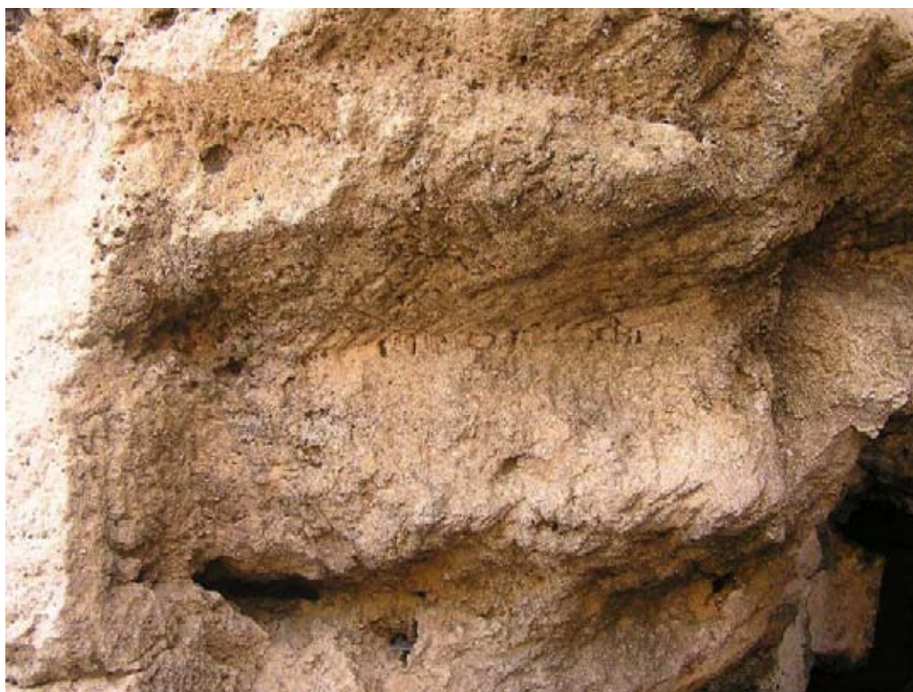
Εικ. X113. Κ. Γαλατάς, Μπαρουταποθήκες, β' υπόγειο λατομείο. Χάραξη ορθογώνιας λιθοπλίνθου στον οριζόντιο άξονα.
