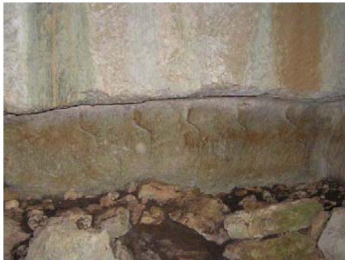
Εικ. P209: Ελεύθερα, Περιστέρες. Κατάρρευση τμήματος της οροφής με παρόμοιους «κάδρους» όπως των εικ. P202 και P207.
