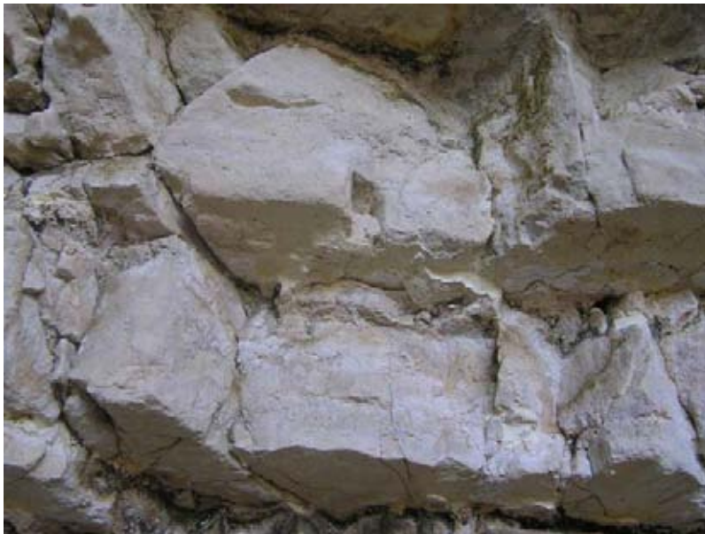
Εικ. X20. Καλαθάς, θέση Βίντζι. Λεπτομέρεια από το εσωτερικό του Λατομείου Α.
