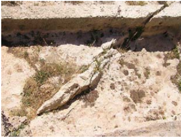
Εικ. X229β: Ρήγμα στο δάπεδο
