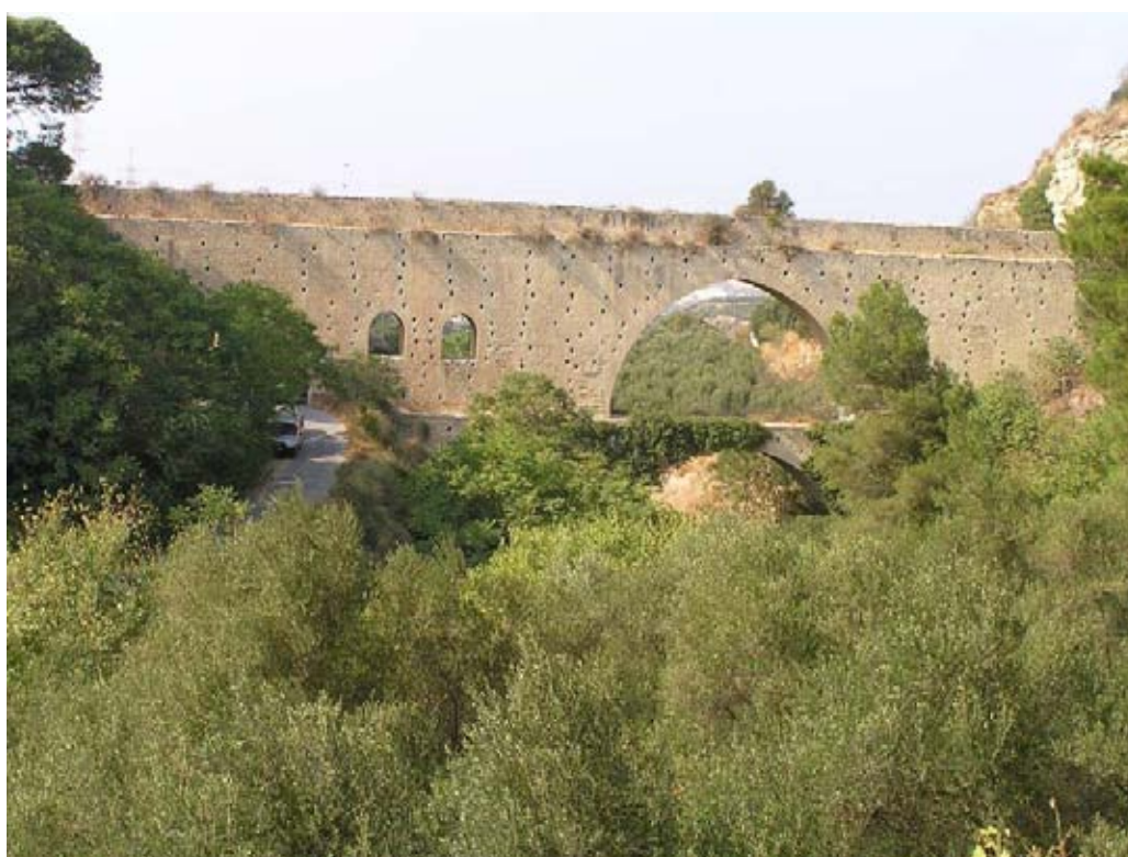
Εικ. Η27. Κνωσός, ρωμαϊκό υδραγωγείο (λήψη από την μεριά της Αγ. Ειρήνης).
