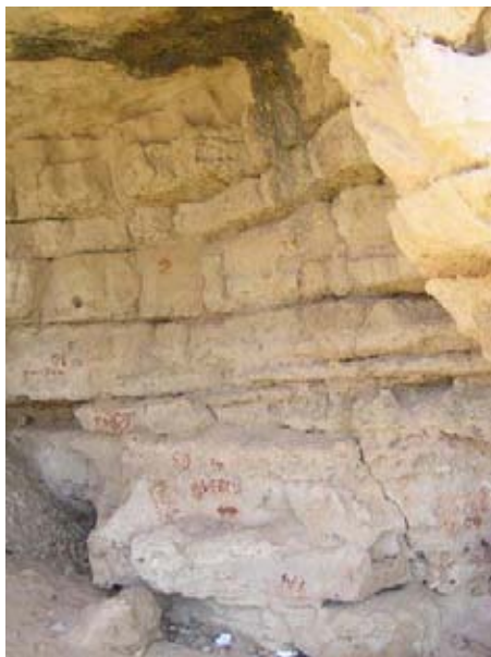
Εικ. X95: Κ. Γαλατάς, Μπαρουταποθήκες. Το εσωτερικό. Στην οροφή φαίνεται η πορεία της λάξευσης.
