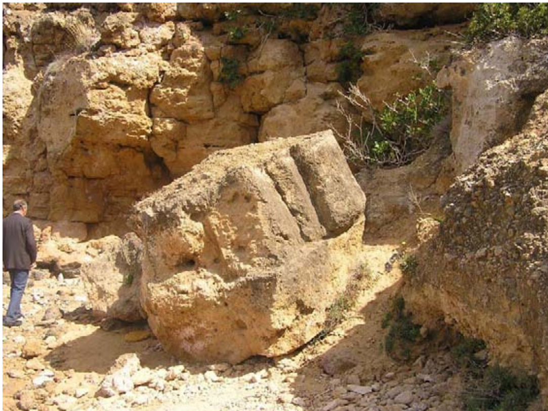
Εικ. X108. Κ. Γαλατάς, Μπαρουταποθήκες, Κατάρρευση ανώτερων τμημάτων του λατομείου στην ακτή.
