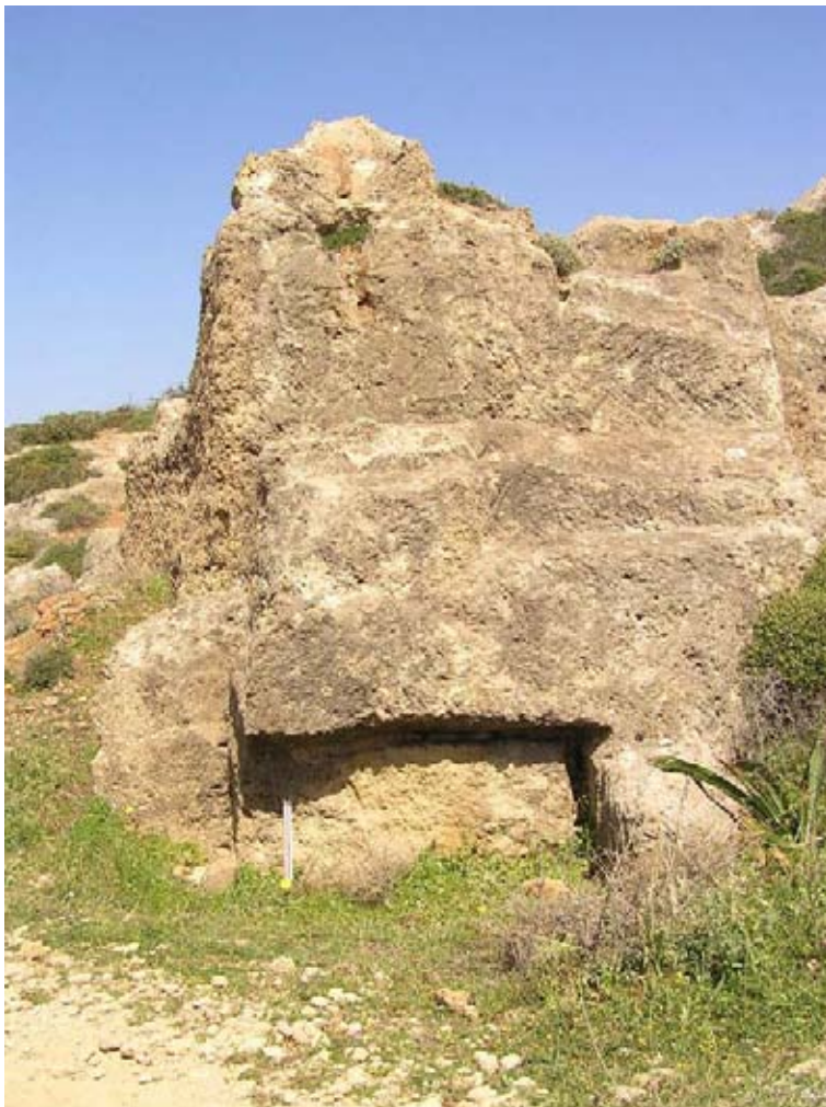
Εικ. 104α: Κ. Γαλατάς, Μπαρουταποθήκες. Ίχνη εργαλείου. Λεπτομέρεια της εικ. 69β.
