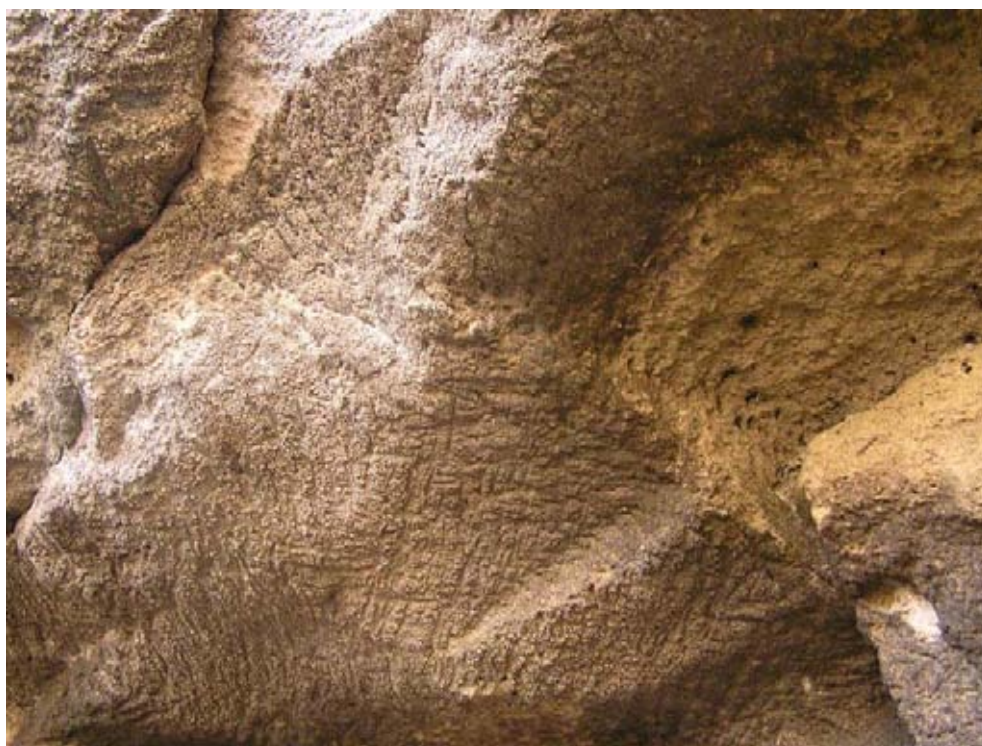
Εικ. X112. Κ.Γαλατάς, Μπαρουταποθήκες. Ίχνη πικουνιού στην οροφή του β' υπόγειου λατομείου.
