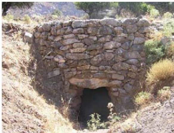
Εικ. Ρ303 α-β: Αποδούλου, ως δομικό υλικό έχει χρησιμοποιηθεί ανοιχτός τεφρός ασβεστόλιθος με χαλαζιακές φλέβες.
