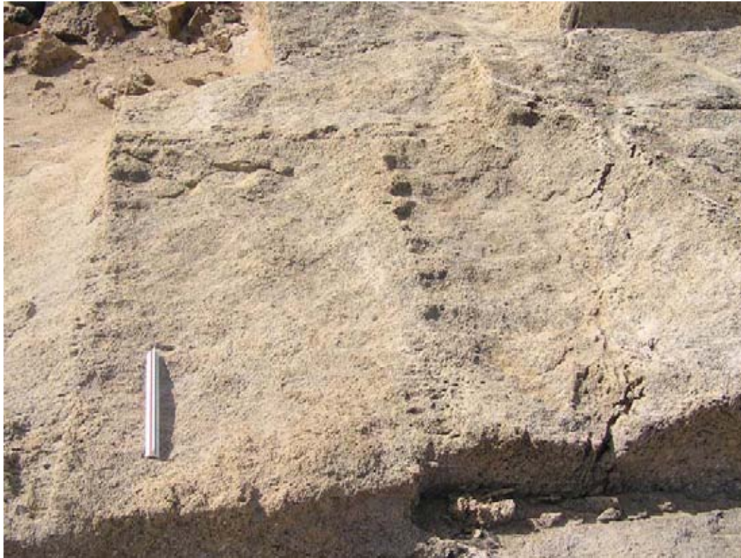
Εικ. X65α. Σταυρός Ακρωτηρίου. Φωλιές σφηνών στο ανατολικό λατομείο.
