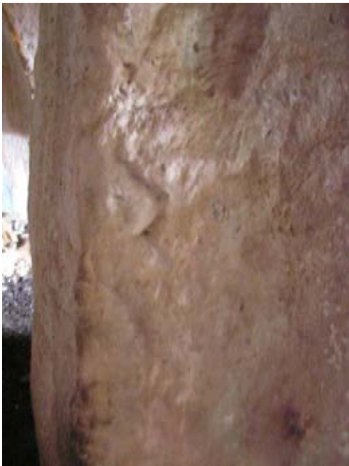
Εικ. P185α: Ελεύθερα, Περιστέρές. Επιπόλαιη αποδυνάμωση του πεσσού στήριξης στο κατώτερο σημείο του. Στο κάτω μέρος της φωτογραφίας οι μη αποκολληθέντες κυβόλιθοι του δαπέδου.
