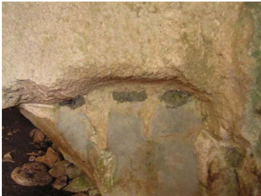
Εικ. P224. Ελεύθερνα. Περιστερές. Ίχνη φωλιών σφηνών σε λιθόπλινθους που δεν αποσπάστηκαν με επιτυχία.
