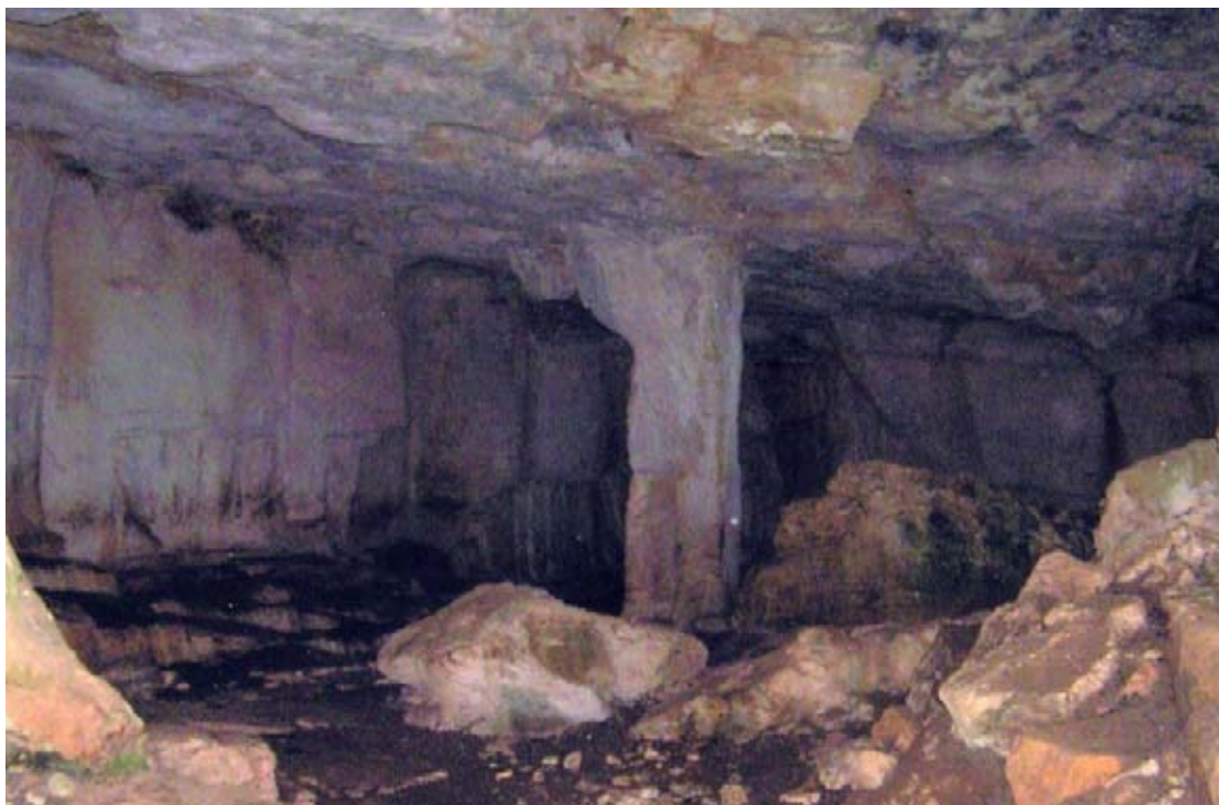
Εικ. P184: Ελεύθερνα, Περιστερές. Άποψη της τελευταίας φάσης του λατομείου με λατομική δραστηριότητα όχι μόνο στα κατώτερα τμήματα των μετώπων εξόρυξης αλλά και στον πεσσό στήριξης.
