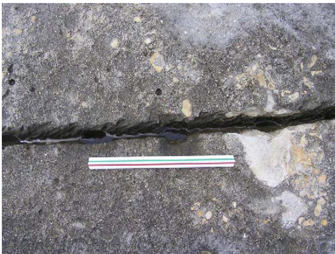
Εικ. X143α-β. Κίσαμος, Βιγλία. Τοποθέτηση κάθετων σφηνών για τη διάρρηξη του πετρώματος.
