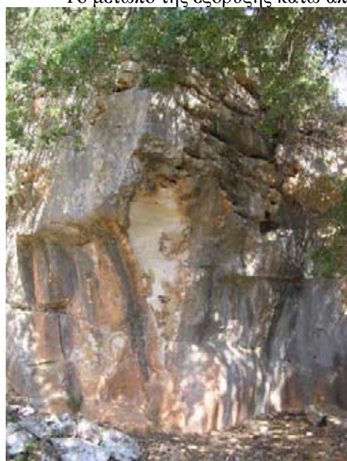
Εικ. Ρ159: Ελεύθερνα, Μνήματα. Το μέτωπο της εξόρυξης κάτω από το στρώμα της βλάστησης. Ύψος περίπου 5μ.
