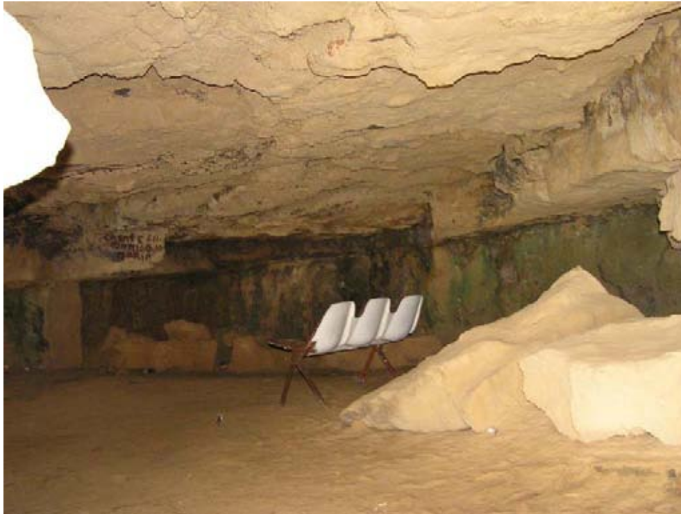
Εικ. X95: Κ. Γαλατάς, Μπαρουταποθήκες. Το εσωτερικό. Στην οροφή φαίνεται η πορεία της λάξευσης.
