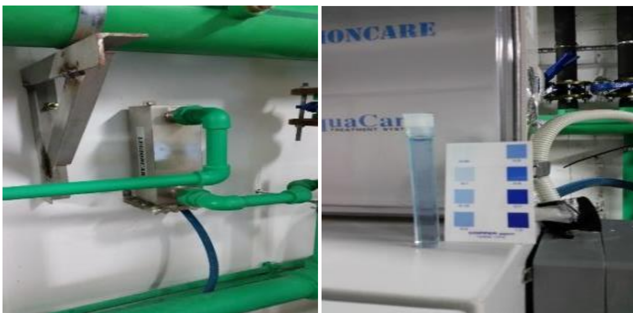
Εικόνα 23: Σύστημα απολύμανσης με ιόντα αργύρου χαλκού και κιτ ελέγχου νερού
