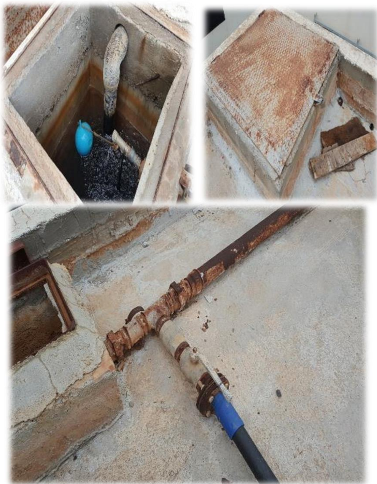
Εικόνα 28: Μια από τις συχνότερες αποκλίσεις από τους προδιαγραφές ασφαλείας για το πόσιμο νερό στα ξενοδοχεία ήταν η απουσία προστασίας της δεξαμενής αποθήκευσης νερού και των σωληνώσεων.
