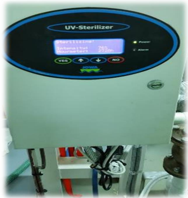
Εικόνα 17: Εικόνα 16: Σύστημα UV με κλειστό κανάλι για απολύμανση πόσιμου νερού.
