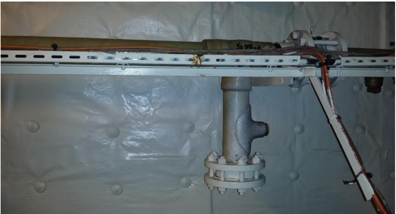
Εικόνα 21: Τυφλό σημείο (dead leg) σε δίκτυο διανομής νερού.
