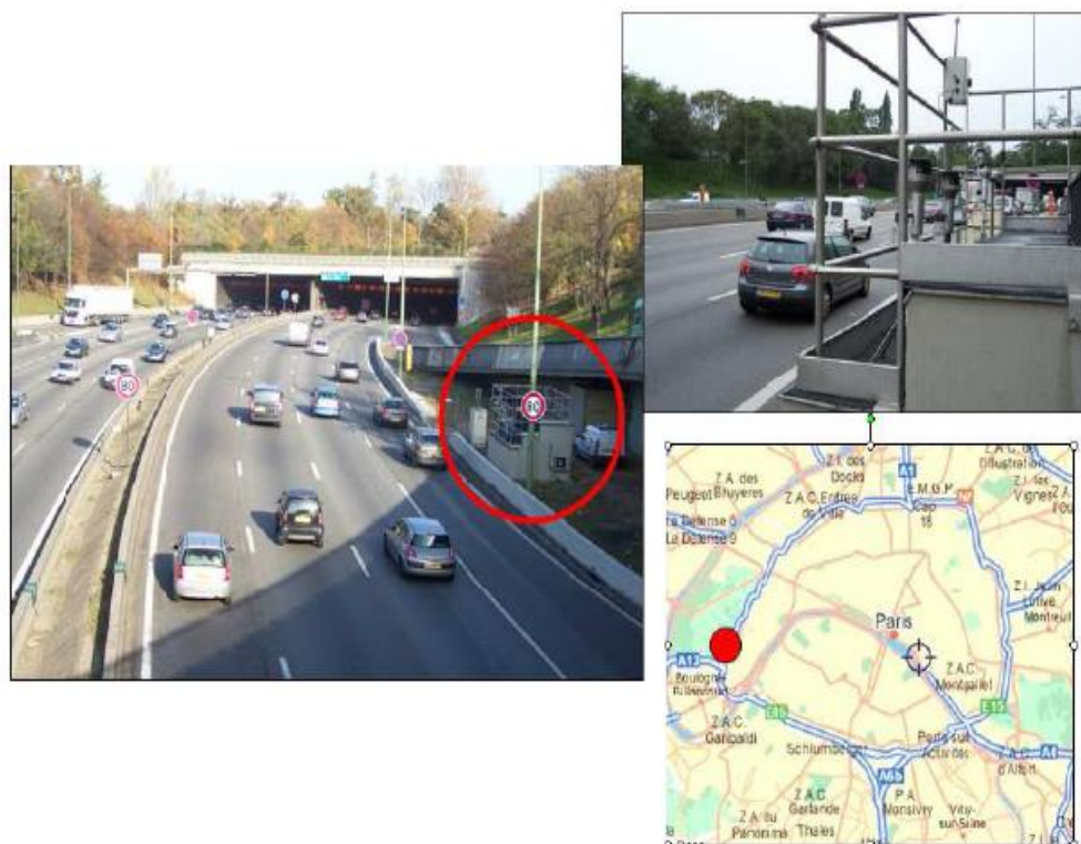
ΕΙΚΟΝΑ 4 :Γεωγραφική θέση και φωτογραφίες του σταθμού "Porte D' Auteuil" στον περιφερειακό αυτοκινητόδρομο του Παρισιού.
