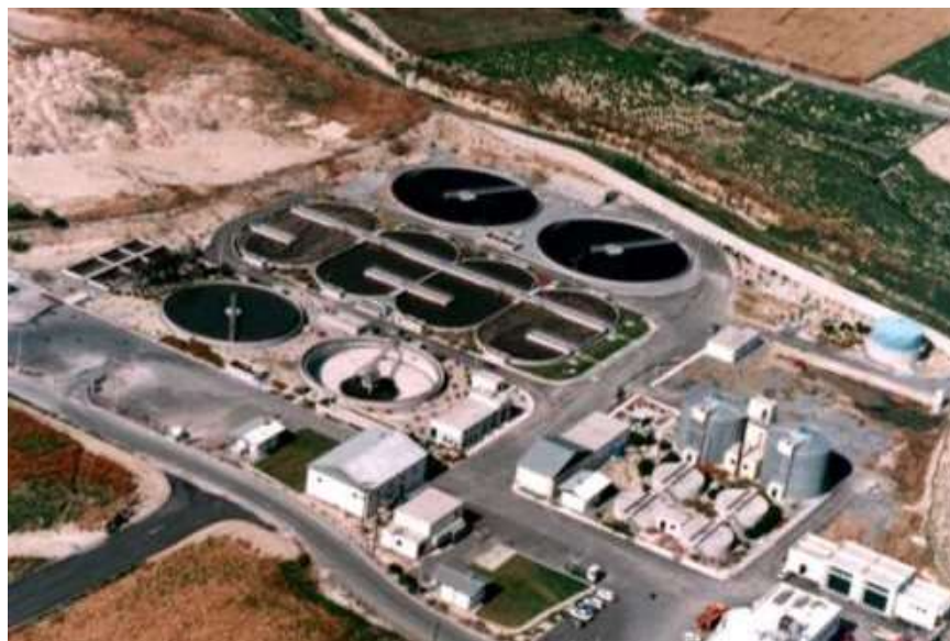
Εικόνα 18 Γενική άποψη των εγκαταστάσεων του Σταθμού Βιολογικού Καθαρισμού αστικών λυμάτων της ΔΕΥΑΗ στην περιοχή Φοινικιά.
