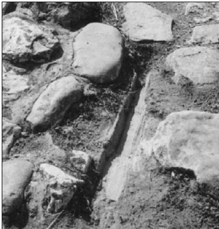
Εικόνα 55. Τμήμα πήλινου αγωγού όμβριων υδάτων στην πόλη των Γουρνιών (Soles 1991, 36, εικ.28).
