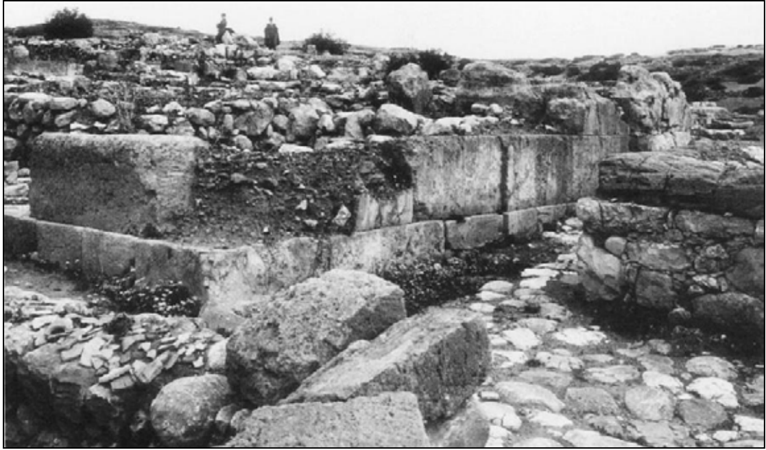
Εικόνα 58. Νοτιοδυτική γωνία του 'ανακτόρου'. Στα θεμέλια του και γύρω του διακρίνονται παλαιότερα οικοδομικά κατάλοιπα (Soles 1991, 46, εικ.38).
