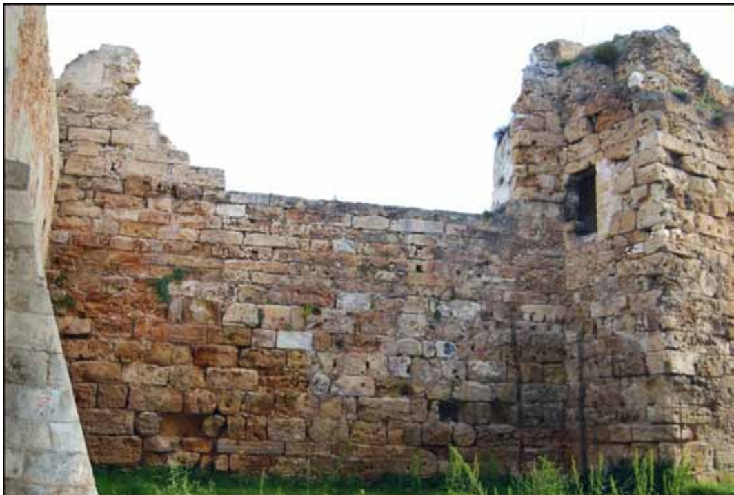
Εικόνα 26. Βυζαντινή οχύρωση στην παλιά πόλη των Χανίων στην οποία έχουν ενσωματωθεί αρχιτεκτονικά μέλη από άλλα κτίσματα (Ανδρεαδάκη-Βλαζάκη 2009α, 27, εικ.13).
