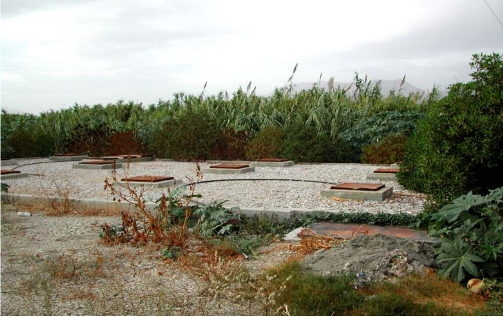
Φωτογραφία 1: Οι σηπτικές δεξαμενές στην είσοδο της εγκατάστασης. Σε πρώτο πλάνο το φρεάτιο άφιξης των λυμάτων (δειγματοληψία δειγμάτων «Raw»). Στο βάθος το ανάντη άκρο του υγρότοπου.
