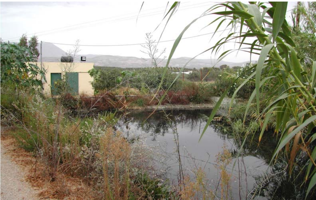
Φωτογραφία 8: Κατάντη άκρο β΄ λεκάνης, ζώνη χωρίς βλάστηση. Στο βάθος διακρίνεται ο οικίσκος ελέγχου και τα σκύρα του κατάντη αναχώματος της λεκάνης.
