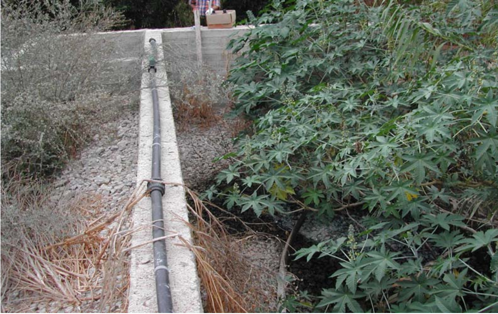
Φωτογραφία 5: Κατάντη άκρο α΄ λεκάνης - Ανάντη άκρο β΄ λεκάνης. Διακρίνονται τα σκύρα (χοντρά χαλίκια) και στο βάθος το φρεάτιο εξόδου της α΄ λεκάνης.
