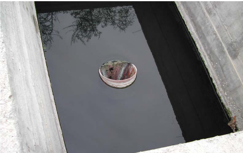
Φωτογραφία 6: Φρεάτιο εξόδου της α΄ λεκάνης, σωλήνα ρύθμισης βάθους
