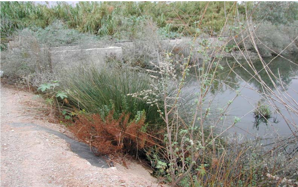
Φωτογραφία 4: Κατάντη άκρο α΄ λεκάνης, ζώνη χωρίς βλάστηση. Στο βάθος διακρίνεται το φρεάτιο εξόδου της λεκάνης και το ανάχωμα διαχωρισμού της α΄ από τη β΄ λεκάνη.
