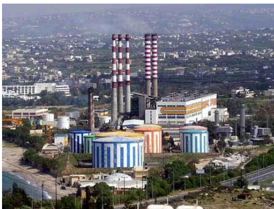
Εικόνα 51: Θερμοηλεκτρικός σταθμός παραγωγής του συστήματος της Κρήτης στα Λινοπεραμάτων Ηρακλείου
