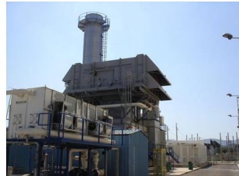
Εικόνα 190: (α) Σχηματική παράσταση αεριοστροβιλικού σταθμού [36]. (β) Μονάδα αεριοστρόβιλου General Electric LM2500 θερμοληκτρικού σταθμού παραγωγής στη Ξυλοκαμάρα Χανίων.
