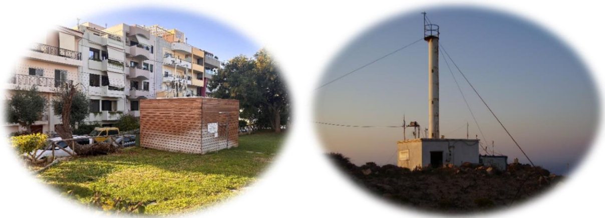
Εικόνα 5: Φωτογραφία του σταθμού του Ηρακλείου (αριστερά) και του σταθμού του Φινοκαλιά (δεξιά).
