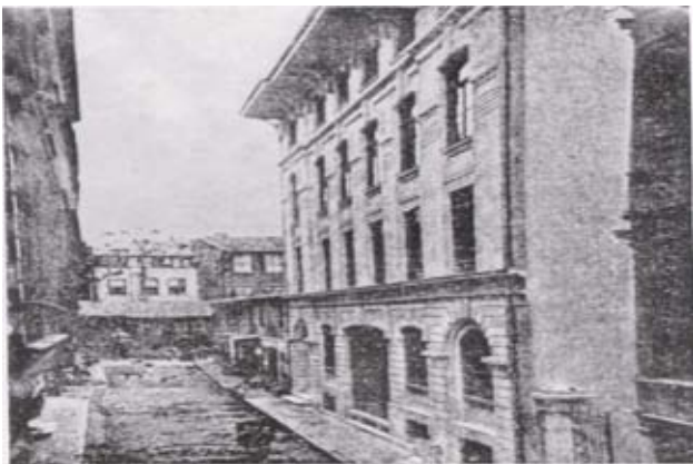
Εικόνα 4: Το κτήριο της Φιλόπτωχου Αδελφότητας των Κυριών του Πέραν.
