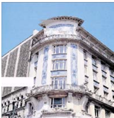
Εικόνα 2 : Το μεγαλόπρεπο κτίριο που στέγαζε το υποκατάστημα της Τραπέζης της Ελλάδος, στα Σκαλάκια, στην αρχή της Μεγάλης Οδού τον Πέρα.
