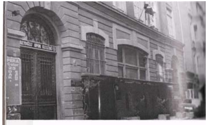
Εικόνα 5: Το κτήριο της Φιλόπτωχου Αδελφότητας των Κυριών του Πέραν όπως είναι σήμερα.
