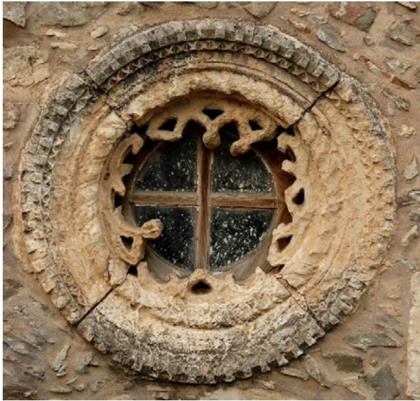
Εικ. 142. Καθολικό Μονής Βαλσαμονέρου, φεγγίτες συναρμωσμένοι από τέσσερα τμήματα.
