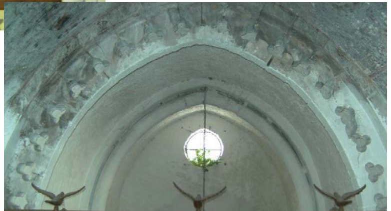
Εικ. 102 γ'. Παναγία στην Αργυρούπολη. Σφενδόνιο διακοσμημένο με διάτρητα τρίλοβα.
