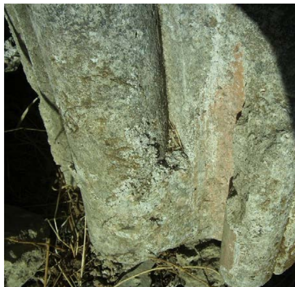
Εικ. 89. Παναγία στην Πατώ Αμαρίου, τμήμα από το λίθινο στεφάνι θόλου: α'. τοποθετημένο οριζόντια, διακρίνεται η ζωγραφική. β'. τοποθετημένο κατακόρυφα, στο πάνω μέρος διακρίνεται η λάξευση, δηλαδή η εσοχή του βεργίου, στο κάτω μέρος διακρίνεται το κονίαμα που γεμίζει την εσοχή δημιουργώντας επίπεδη επιφάνεια.
