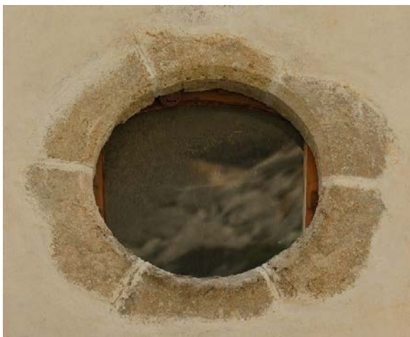
Εικ. 144. Άγιος Αντώνιος στο Αγιοφάραγγο Καινούριου, φεγγίτης συναρμωσμένος από έξι τμήματα.
