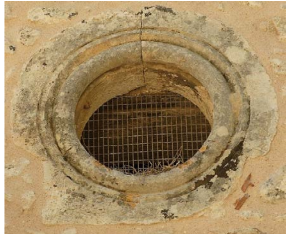
Εικ. 143. Παναγία-Μιχαήλ Αρχάγγελος στα Βλαχιανά Μαλεβιζίου, φεγγίτες συναρμωσμένοι από τρία τμήματα.
