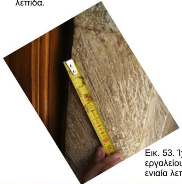
Εικ. 52 β'. Ίχνη εργαλείου με οδοντωτή λεπίδα.
