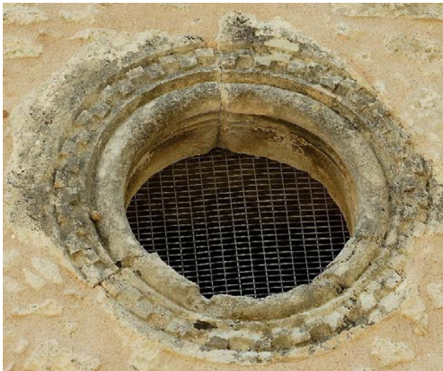
Εικ. 143. Παναγία-Μιχαήλ Αρχάγγελος στα Βλαχιανά Μαλεβιζίου, φεγγίτες συναρμωσμένοι από τρία τμήματα.
