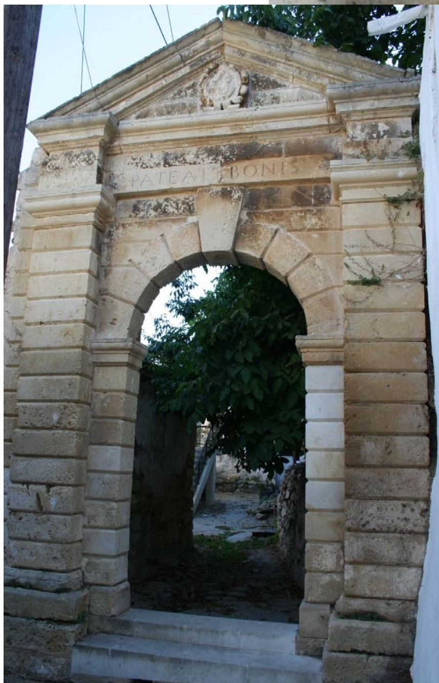
Εικ. 184. Θύρωμα κατοικίας στον Πίκρη Ρεθύμνου. Λοξότμητοι ψευδοαρμοί στο τόξο.
