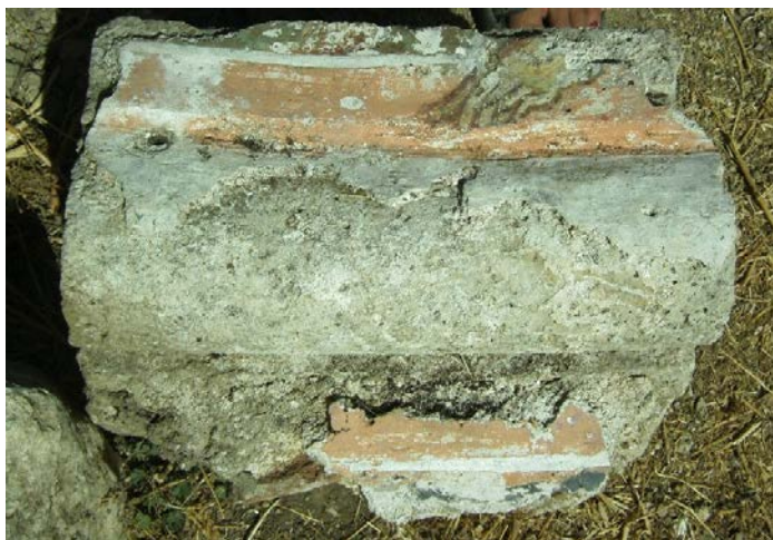
Εικ. 89. Παναγία στην Πατώ Αμαρίου, τμήμα από το λίθινο στεφάνι θόλου: α'. τοποθετημένο οριζόντια, διακρίνεται η ζωγραφική. β'. τοποθετημένο κατακόρυφα, στο πάνω μέρος διακρίνεται η λάξευση, δηλαδή η εσοχή του βεργίου, στο κάτω μέρος διακρίνεται το κονίαμα που γεμίζει την εσοχή δημιουργώντας επίπεδη επιφάνεια.
