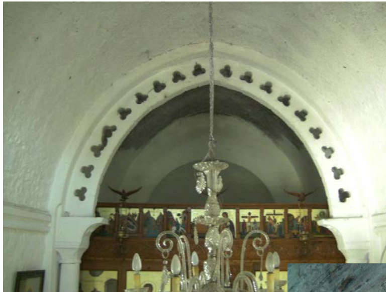
Εικ. 102 γ'. Παναγία στην Αργυρούπολη. Σφενδόνιο διακοσμημένο με διάτρητα τρίλοβα.
