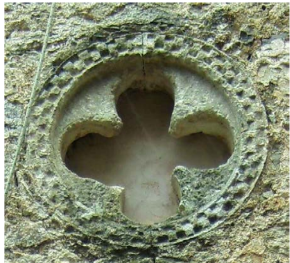
Εικ. 145. Άγιος Γεώργιος στο Τουπάκι, Επισκοπή Πεδιάδος, φεγγίτης συναρμωσμένος από τέσσερα τμήματα.
