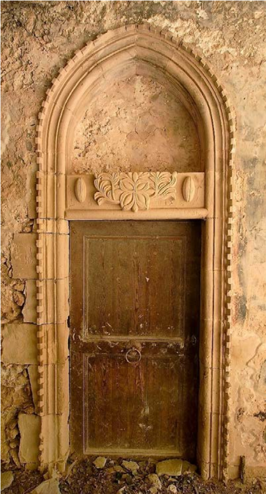
Εικ. 121. Παναγία στον Πρίνο Μυλοποτάμου. Δυτικό θύρωμα. Μικρού ύψους τμήμα λίθου στο πάνω μέρος της αριστερής παραστάδας.
