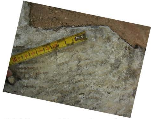
Εικ. 52 β'. Ίχνη εργαλείου με οδοντωτή λεπίδα.
