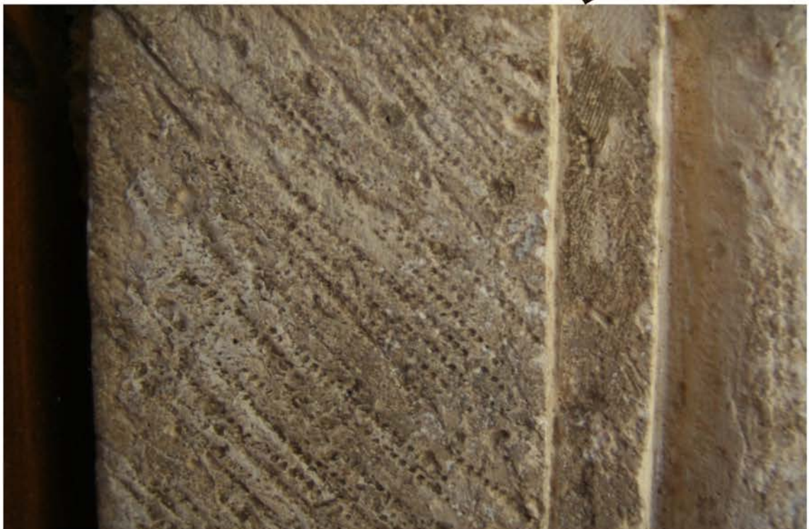
Εικ. 54. Ίχνη από φαρδιά οδοντωτή λεπίδα και ίχνη από μικρότερη ενιαία λεπίδα.
