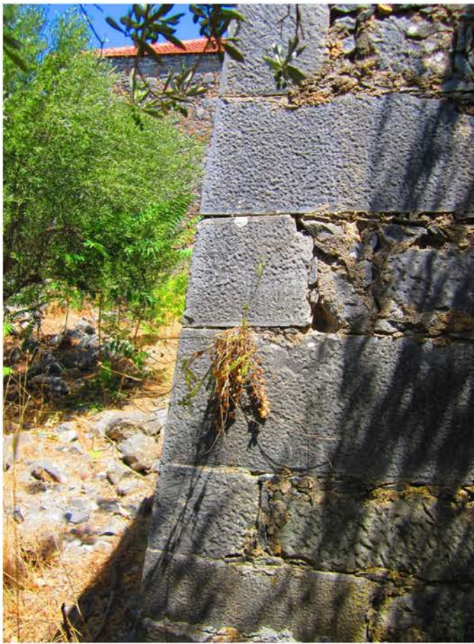
Εικ. 66. Παναγία Κερατολίτισσα στη Φουρνή Μεραμπέλλου. Σκάρπα και λεπτομέρεια αναθύρωσης.
