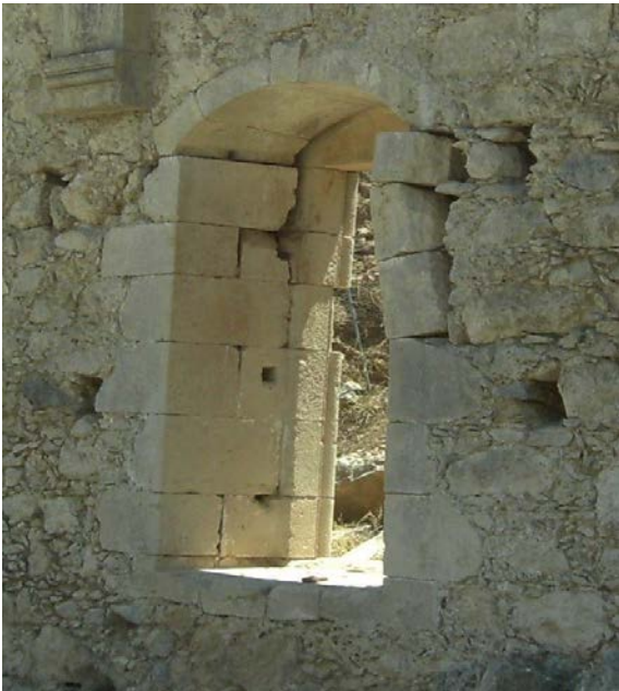
Εικ. 123 α'. Άγιος Αντώνιος στο Πετάλι Μαλεβιζίου. Νότιο θύρωμα χτισμένο σε όλο το βάθος με ανισοϋψείς λίθους.
