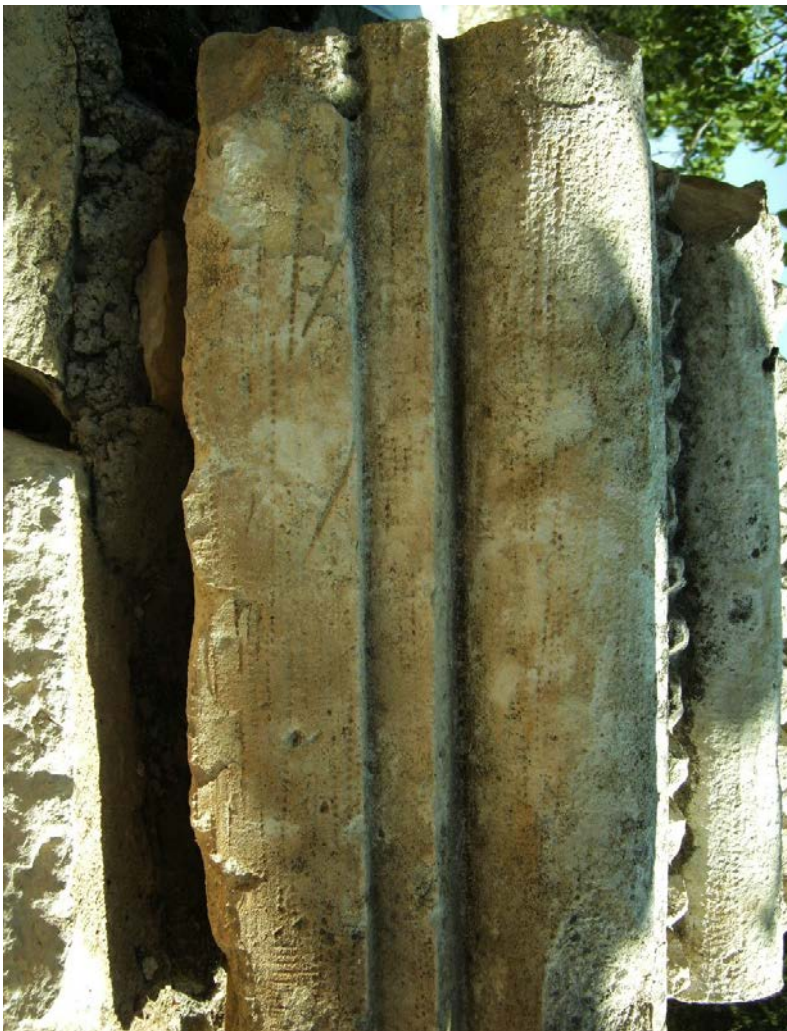
Εικ. 58 α'. Ίχνη οδοντωτής λεπίδας.
