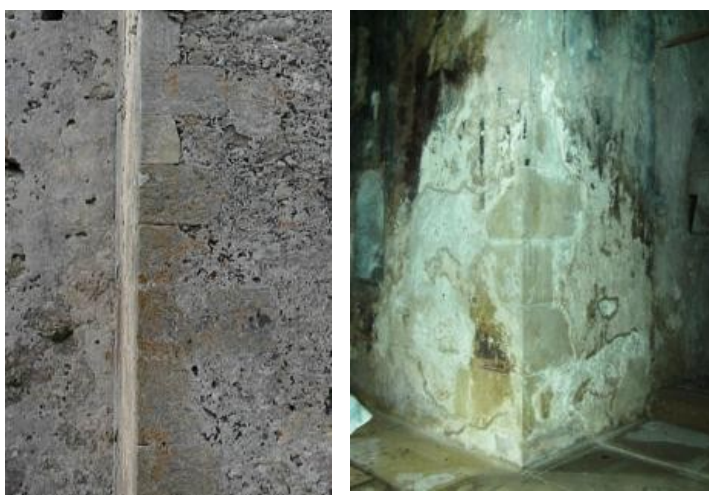
Εικ. 80. Παναγία στον Πρίνο Μυλοποτάμου. Ορθογωνισμένοι γωνιόλιθοι στο εξωτερικό και το εσωτερικό του ναού.
