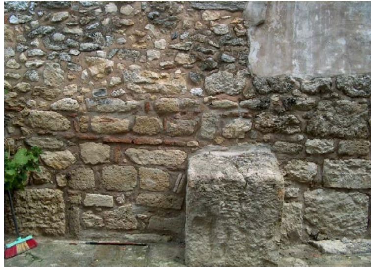
Εικ. 83. Άγιος Θωμάς στον Άγιο Θωμά Μονοφατσίου. Νότιος τοίχος, η κατώτερη ζώνη του τοίχου με τους μεγάλους ημίεργους λίθους χρονολογείται στη μεσοβυζαντινή περίοδο.
