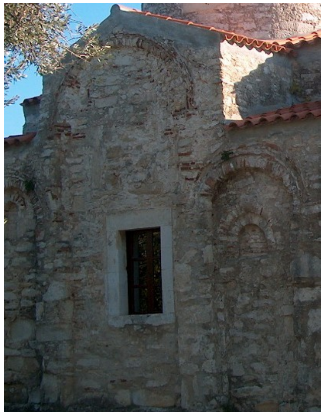
Εικ. 85. Άγιος Γεώργιος στον Καλαμά Μυλοποτάμου (μεσοβυζαντινός ναός). Τόξα από πλίνθους, λίθους και κονίαμα.
