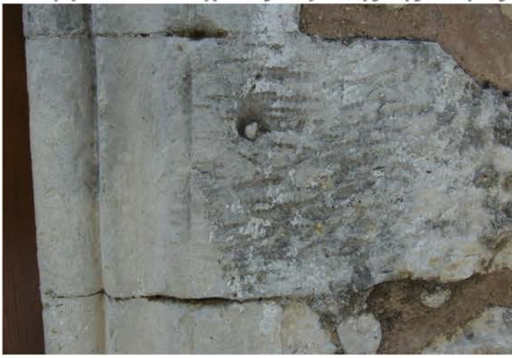
Εικ. 52 α'. Ίχνη εργαλείου με οδοντωτή λεπίδα.
