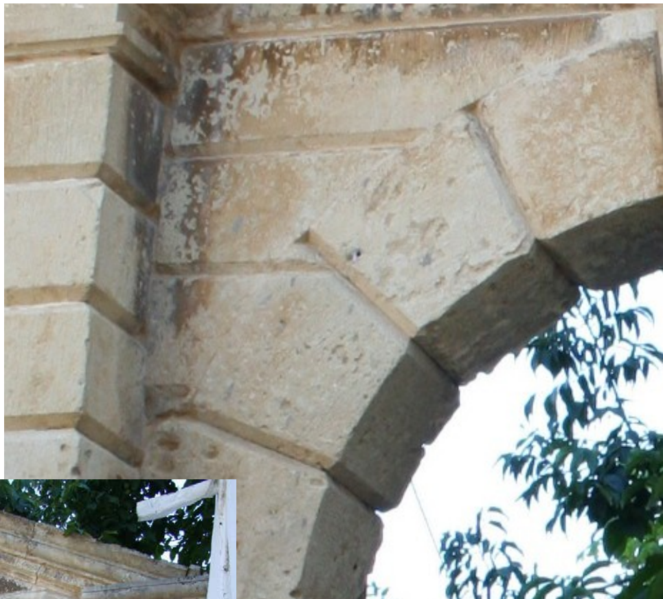
Εικ. 184. Θύρωμα κατοικίας στον Πίκρη Ρεθύμνου. Λοξότμητοι ψευδοαρμοί στο τόξο.
