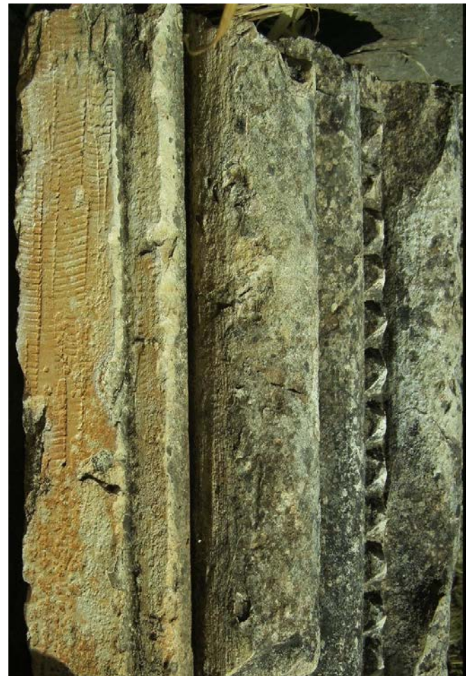
Εικ. 58 β'. Ίχνη οδοντωτής λεπίδας.
