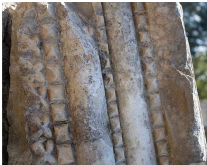
Εικ. 61. Ίχνη από κρουόμενο εργαλείο.
