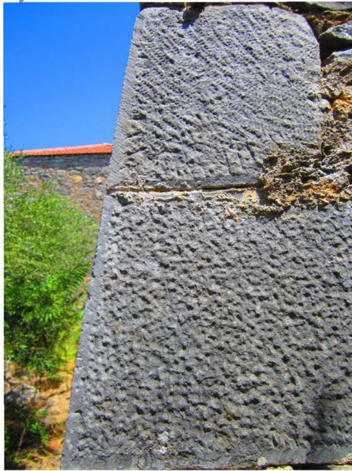
Εικ. 66. Παναγία Κερατολίτισσα στη Φουρνή Μεραμπέλλου. Σκάρπα και λεπτομέρεια αναθύρωσης.
