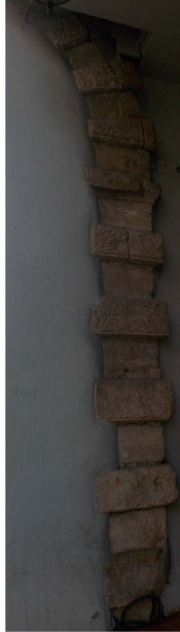
Εικ. 182. Το τόξο του πύργου του ρολογιού στο Ρεθυμνο. Στη λεπτομέρεια φαίνεται ένας τοξωτός αρμός κοινός για τρεις φαινομενικά διαφορετικούς τοξωτούς λίθους.
