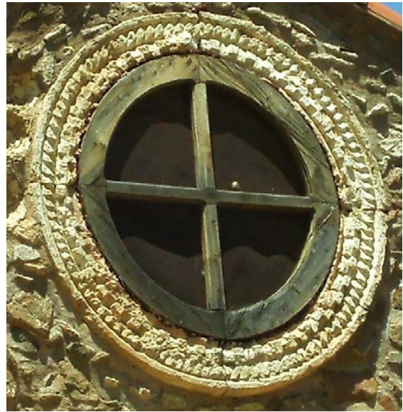
Εικ. 142. Καθολικό Μονής Βαλσαμονέρου, φεγγίτες συναρμωσμένοι από τέσσερα τμήματα.
