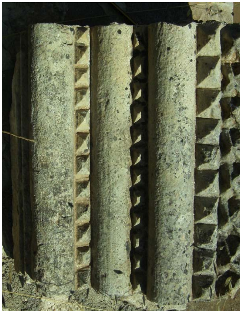
Εικ. 60. Ίχνη από κρουόμενο εργαλείο με οδοντωτή λεπίδα.
