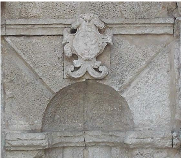
Εικ. 181 β'. Οι διαγώνιοι «αρμοί» είναι επιφανειακοί, δεν συνεχίζουν στο εσωτερικό της κόγχης.
