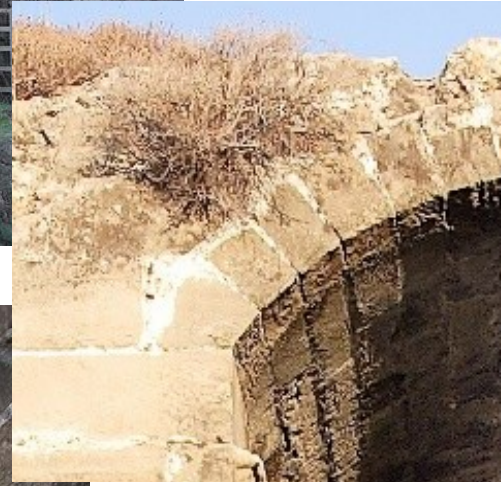
Εικ. 177 γ'. Η γένεση του τόξου, λεπτομέρεια της φωτογραφίας α'.
