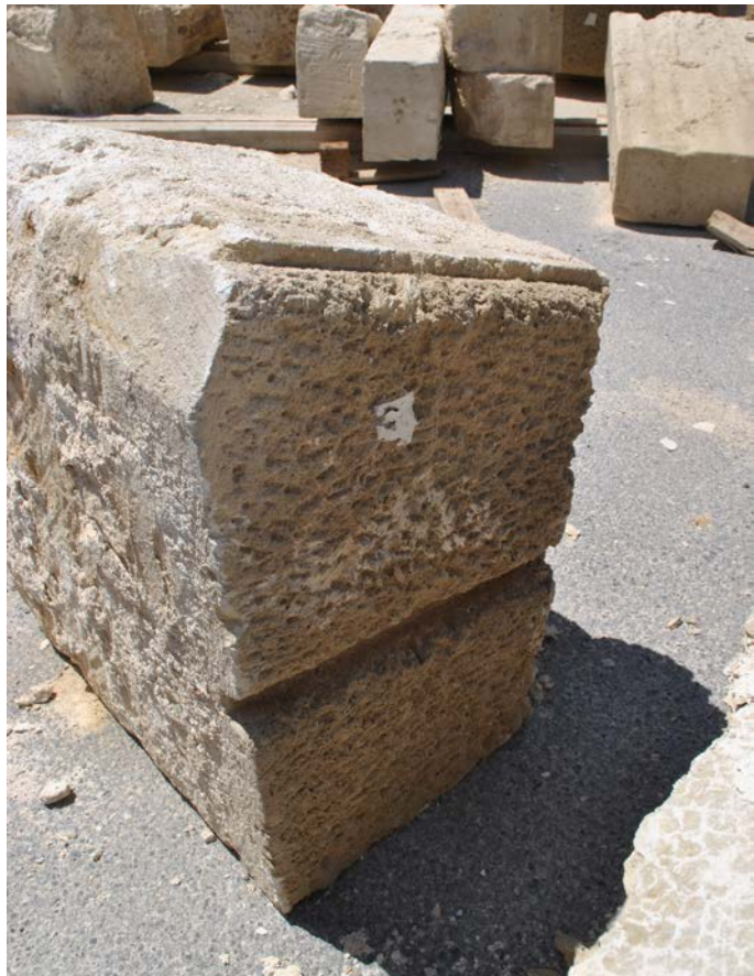
Εικ. 183. Τμήμα τόξου από την Πύλη του Ιησού στο Ηράκλειο. Διακρίνεται ότι ο τονισμένος «αρμός» είναι μόνο επιφανειακός.
