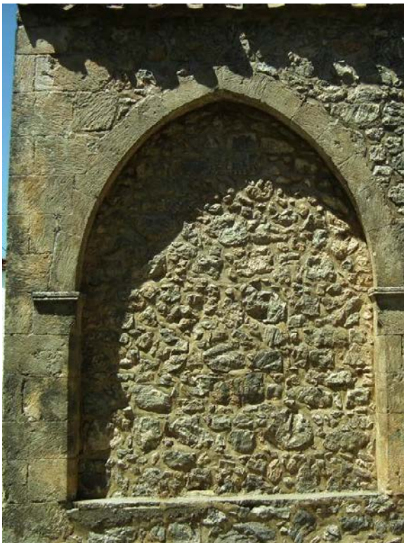
Εικ. 84. Μιχαήλ Αρχάγγελος στο Μοναστηράκι Αμαρίου. Τόξο από λαξευτούς θολίτες που συνδέονται με αφανή αρμό.
