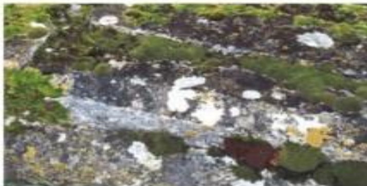
Σχήμα 12 Πράσινα βρύα, άσπρες και κίτρινες λειχήνες πάνω σε ταφόπλακα [42]
