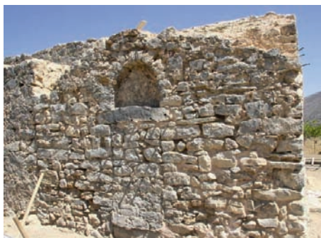
Εικ. 12. Ναός Αγίου Πνεύματος στο Λιμνάκαρο. Η δυτική όψη του νότιου κλίτους μετά τις καθαιρέσεις και την αφαίρεση των στηθαίων. Διακρίνεται η τοιχισμένη αρχική θύρα του ναού.
