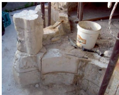
Εικ. 20. Συμπλήρωση με νέους λίθους και τοποθέτηση ανοξειδωτων συνδέσιμων για τη συγκόλληση.
