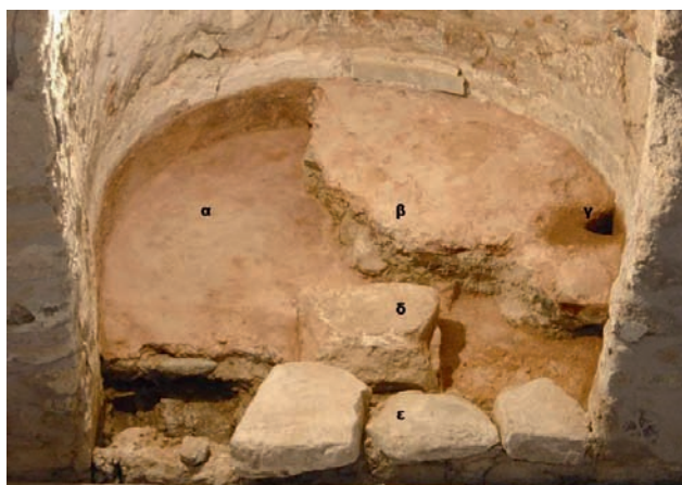
Εικ. 2. Νότια κόγχη: (α, β) δάπεδα από υδραυλικό κονίαμα, (γ) οπή απορροής υδάτων, (δ) κτιστό κάθισμα, (ε) σιτηαίο.
