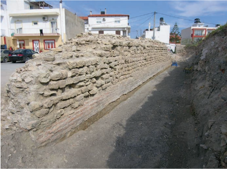
Εικ. 5. Ανατολικό σκέλος τείχους, άποψη τμήματος νότιας παρειάς.
