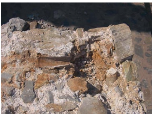
Εικ. 3. Το σύστημα απορροής του βρόχινου νερού στη νοτιοδυτική γωνία του ναού.
