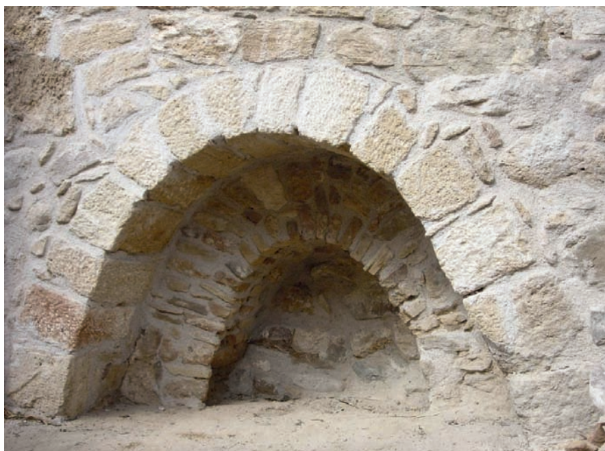
Εικ. 4. Τοξωτό άνοιγμα στη βάση του ανατολικού τοίχου.
