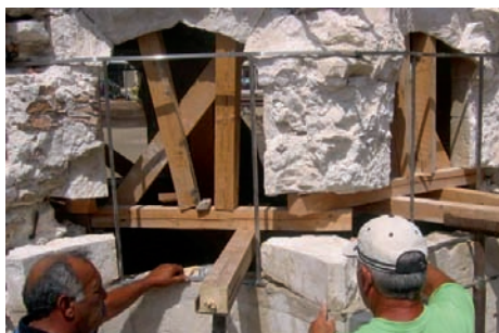
Εικ. 22. Τοποθέτηση νέων μεταλλικών πλαισίων παραθύρων.
