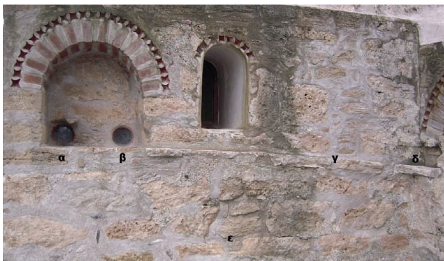
Εικ. 3. Ανατολικό τμήμα βόρειου τοίχου: είσοδος νερού προς (α) νότια κόγχη, (δ) βόρεια κόγχη, (ε) ανατολικό διαμέρισμα και: (β) έξοδος υδρατμών, (γ) πατάρι στήριξης αγωγού.
