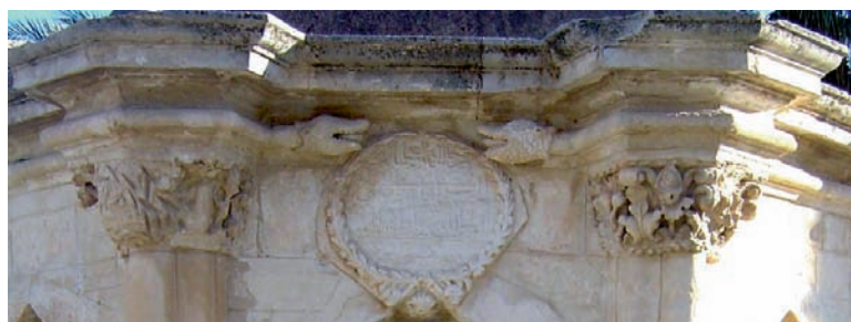
Εικ. 7. Η απόληξη του κορδονιού που περιτρέχει την ανώτερη ζώνη του κτηρίου.
