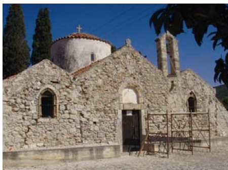
Εικ. 1. Κερά Κριτσάς. Η δυτική όψη μετά τις καθαυρέσεις των εξωτερικών επιχρισμάτων.
