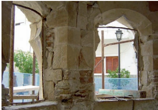
Εικ. 12. Μεταλλικά πλαίσια παραθύρων.
