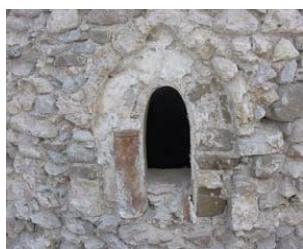
Εικ. 2. Κερά Κριτσάς. Το δυτικό παράθυρο του τρούλλου με το λωβόσχημο πλαίσιο σε εσοχή. Η κεραμίδα χρησιμοποιήθηκε σε β' χρήση για το κλείσιμο της εσοχής.
