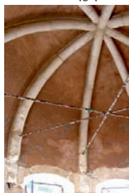
Εικ. 8. Οι λίθινες νευρώσεις εσωτερικά του τρούλλου.
