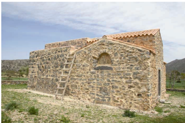
Εικ. 14. Ναός Αγίου Πνεύματος στο Λιμνάκαρο. Η δυτική όψη μετά τις εργασίες αναστήλωσης.
