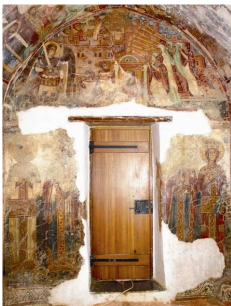
Εικ. 6. Δυτική πλευρά.
