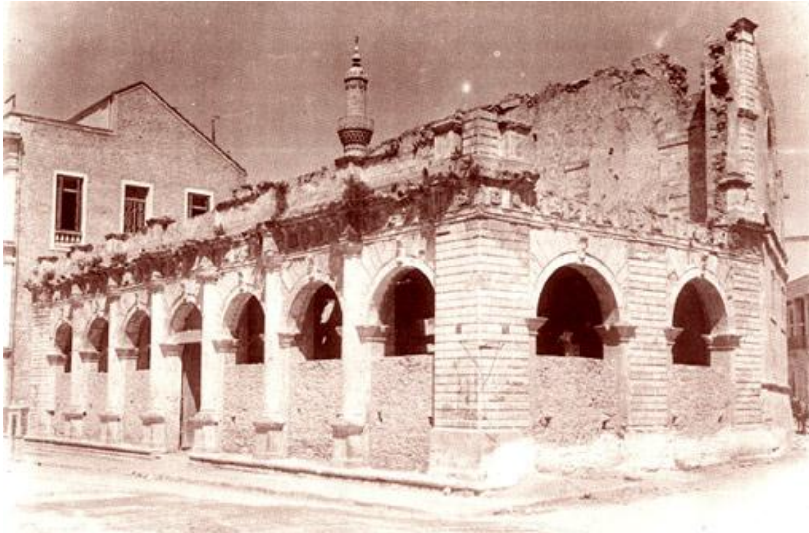
Εικ. 263. Φωτογραφία της Λότζιας IV μετά την κατεδάφιση του ορόφου. Διακρίνονται στον ανατολικό τοίχο της Λότζιας δύο από τα τόξα που συνέδεαν την Λότζια με την Οπλοθήκη, τα οποία κλείστηκαν κατά την οθωμανική περίοδο.
