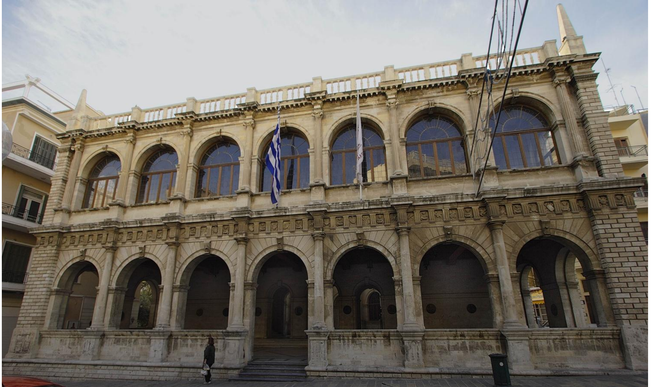
Εικ. 85. Η ανακατασκευασμένη Λότζια του Ηρακλείου. Παρά τις πολλές διαφορές από το πρωτότυπο μπορεί να δώσει μια εικόνα της ρυθμικότητας. Διαφορές: στη Λότζια του 17 ου αιώνα υπήρχε κεραμοσκεπή και όχι επίστεψη με κιονίσκους. Αντί για στηθαίο στο ισόγειο υπήρχαν κιονίσκοι. Τα τόξα του ορόφου ήταν εναλλάξ κλειστά και ανοιχτά.
