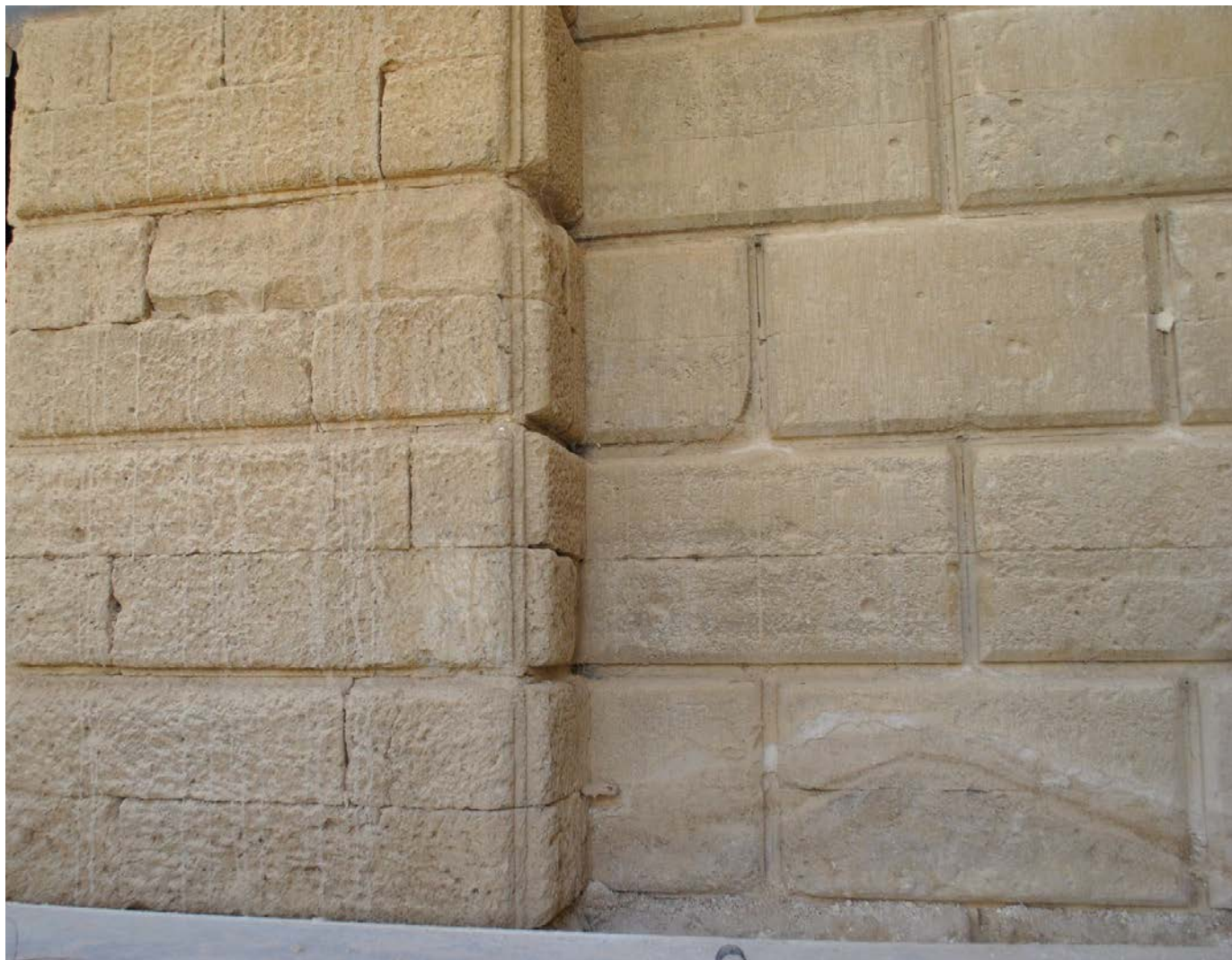
Εικ. 81. Λεπτομέρειες δόμων της πύλης του Ιησού του Χάνδακα (1587), όπου φαίνεται ότι κάποιοι από τους αρμούς είναι επιφανειακοί και δεν αντιστοιχούν στους πραγματικούς αρμούς
