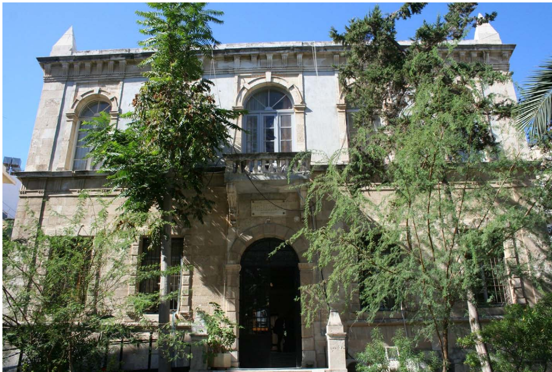
Εικ. 277. Ανακατασκευασμένη ανατολική πρόσοψη της Οπλαποθήκης του Χάνδακα, Δημαρχείο Ηρακλείου (1932-1934).
