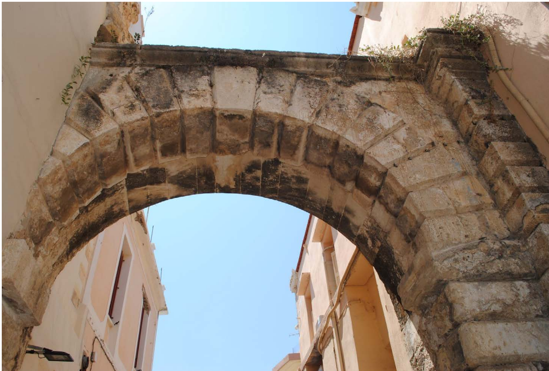
Εικ. 186. Λεπτομέρεια από τη εσωτερική όψη της πύλης Guora (Μεγάλη Πύλη) του Ρεθύμνου όπως σώζεται σήμερα, 1556-1568.
