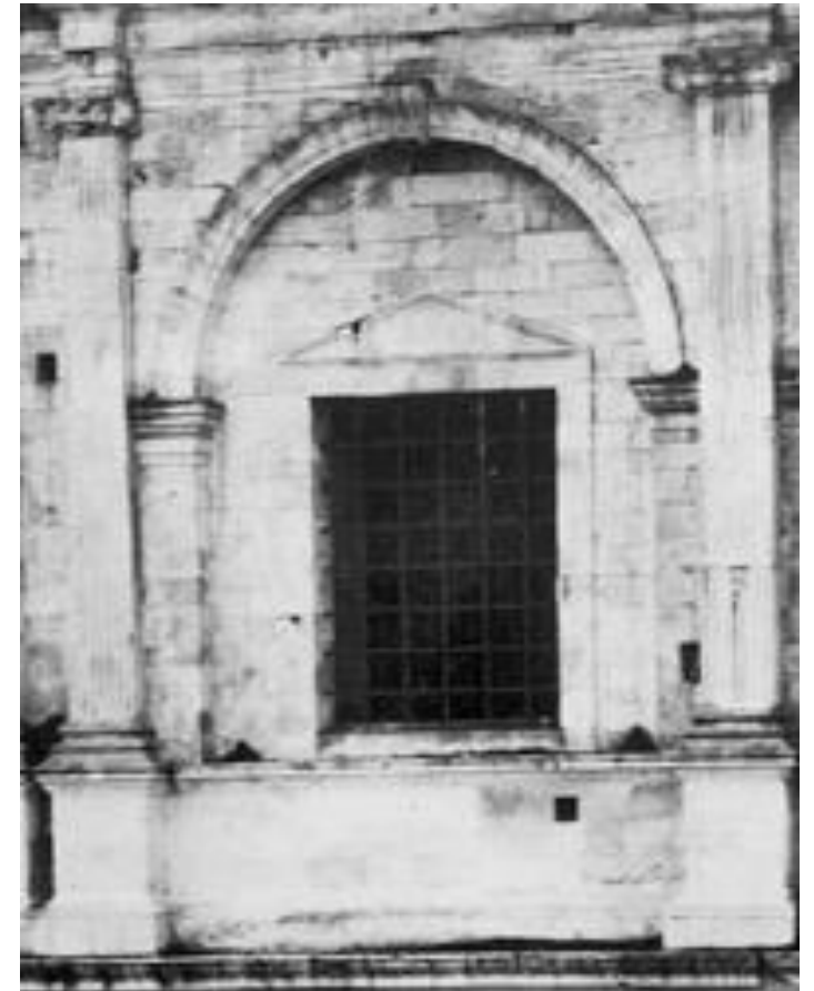
Εικ. 67. Τόξο ορόφου της βόρειας όψης της Λότζιας IV.
