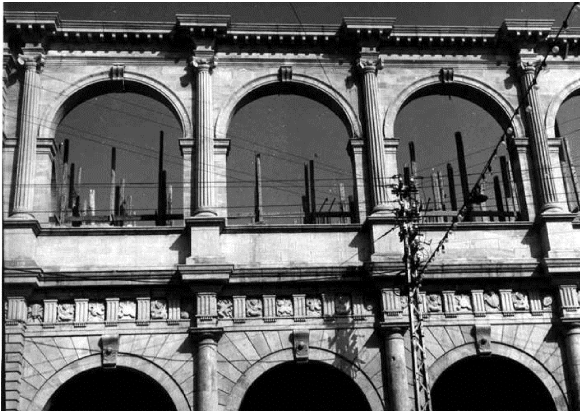
Εικ. 282. Η Λότζια V υπό κατασκευή, 1964- 1965.
