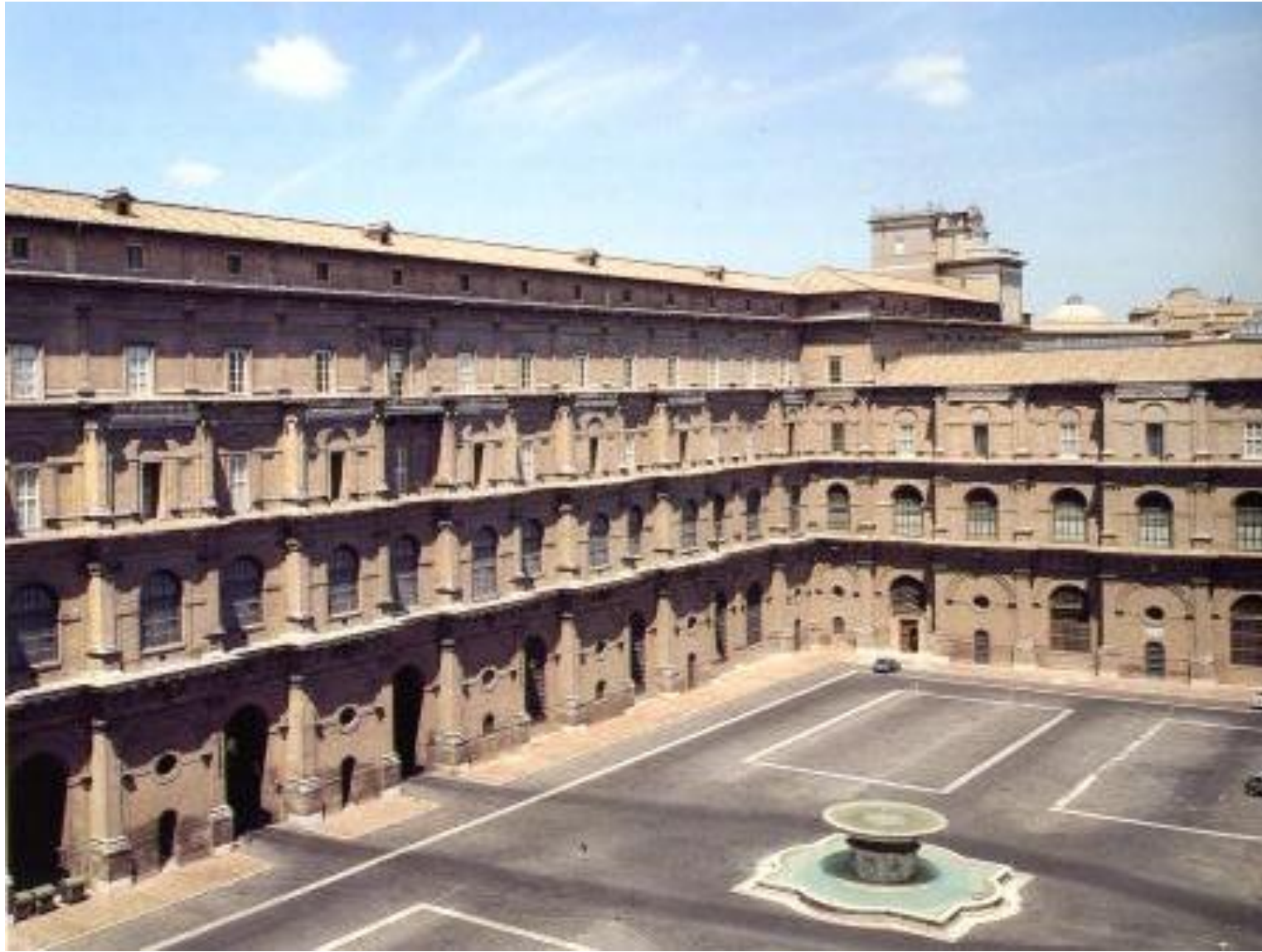
Εικ. 139. Donato Bramante, Cortile del Belvedere, Ρώμη, η κατασκευή ξεκίνησε το 1505.
