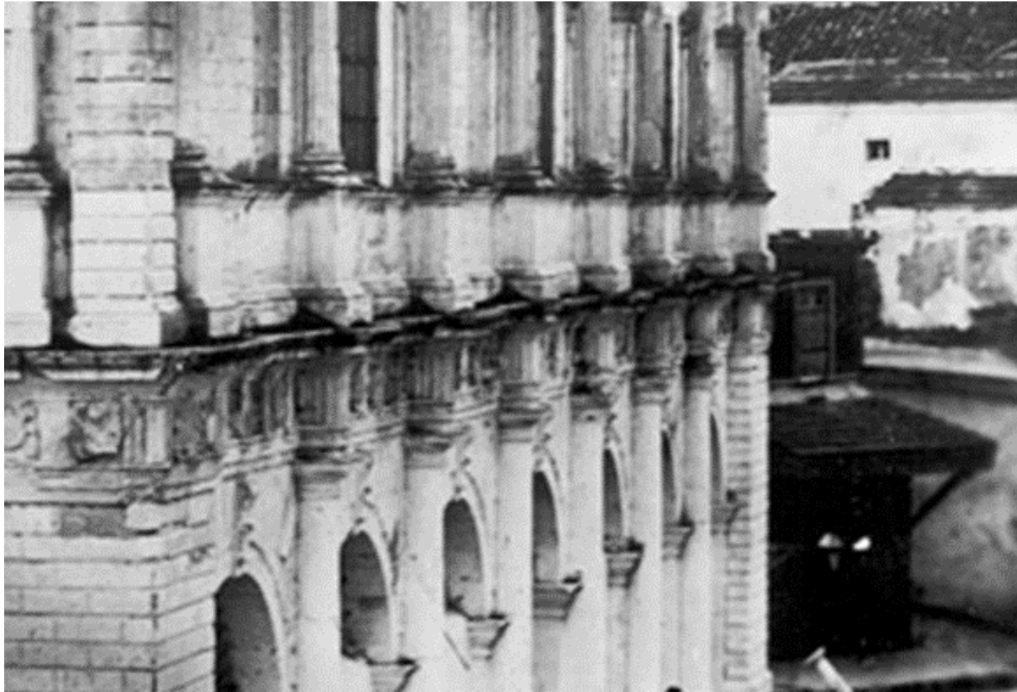
Εικ. 72. Βάθρα ημικιώνων και στηθαίο ορόφου. Γενική άποψη και λεπτομέρεια.
