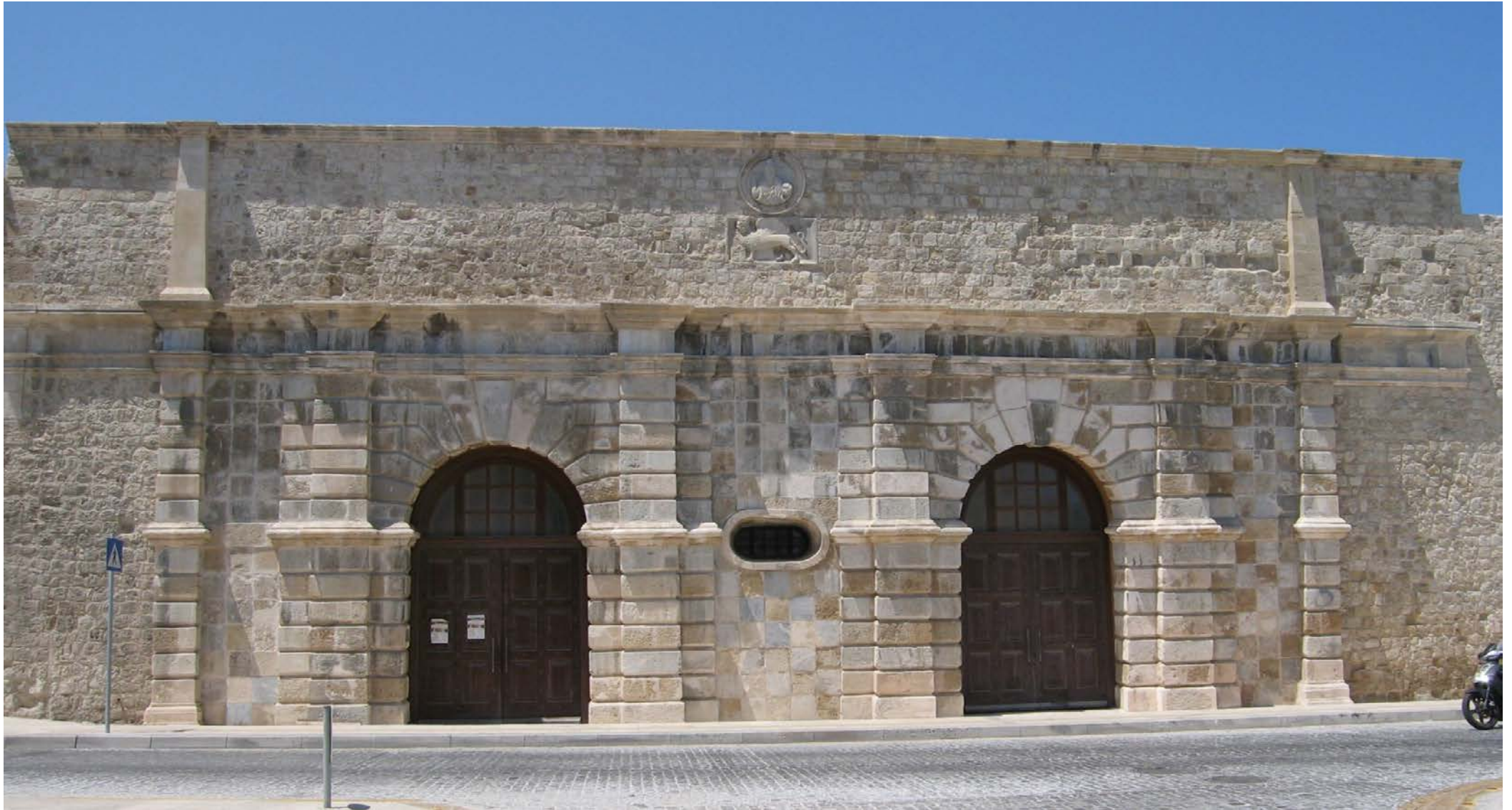
Εικ. 185. Εσωτερική όψη πύλης Παντοκράτορα, Ηράκλειο, 1567-1570.
