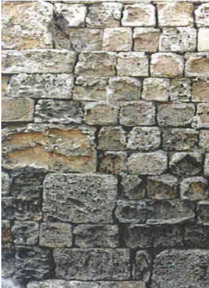
Εικόνα 3.9: Εμφάνιση κυψέλωσης στο τείχος της Μεσαιωνικής Πόλης της Ρόδου.
