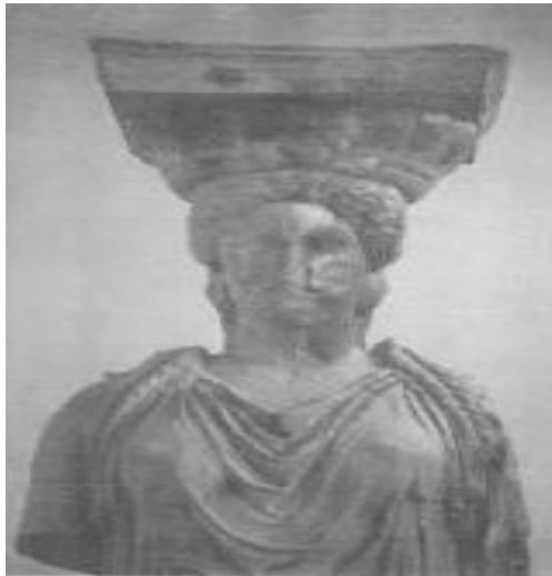
Εικόνα 3.2: Αλλοίωση χαρακτηριστικών στο πρόσωπο Καρυάτιδας, λόγω γυψοποίησης
