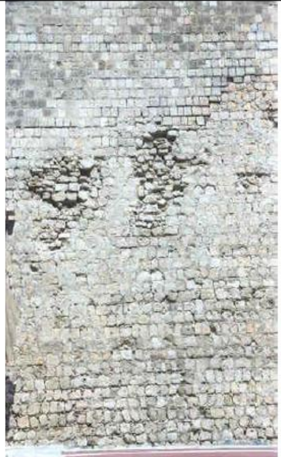
Εικόνα 3.10: Εμφανή τμήματα με κυψέλωση στο τείχος του Εθνικού Σταδίου Ηρακλείου
