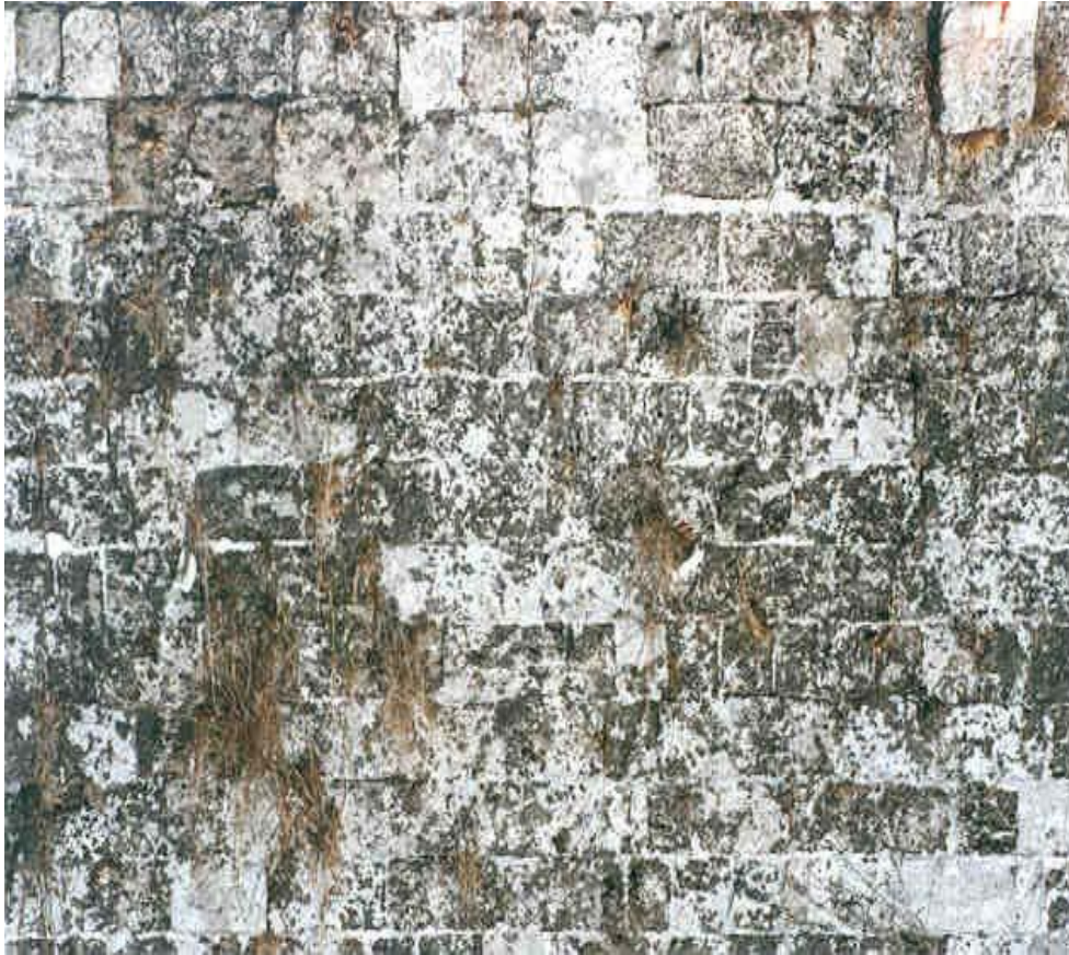
Εικόνα 3.19: Ανάπτυξη βιολογικής κρούστας με μαύρο και γκριζο χρώμα, σε τοίχος της Μεσαιωνικής πόλης της Ρόδου
