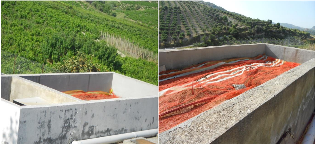
Εικόνα 2.2: Μονάδα εξουδετέρωσης οσμερίων της σηπτικής δεξαμενής.
