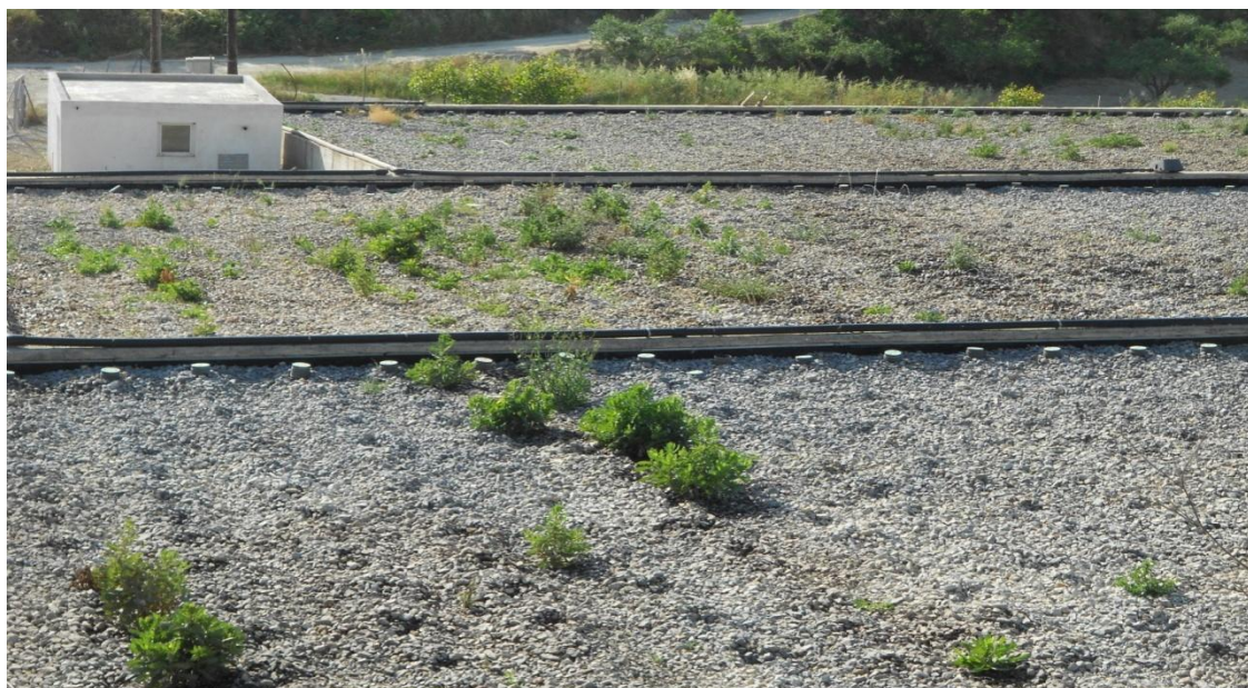
Εικόνα 2.5: Εγκατάσταση επεξεργασίας υγρών αποβλήτων στον οικισμό Δαφνών.
