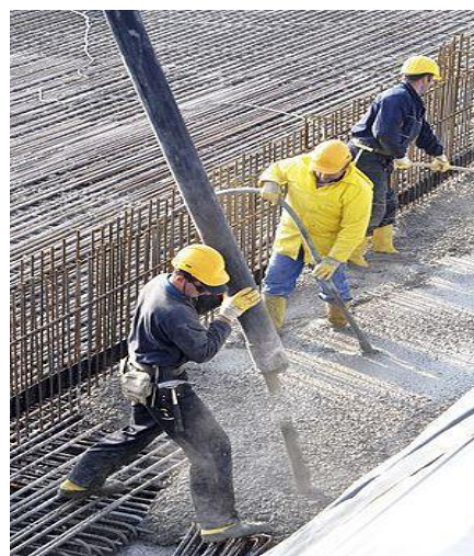
Εικόνα 2. Εργασία σκυροδέτησης
