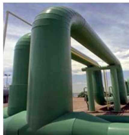
Εικόνα 1.3 Μεταφορά υδρογόνου σε αγωγούς (πηγή: U.S. Department of Energy Hydrogen Program )
