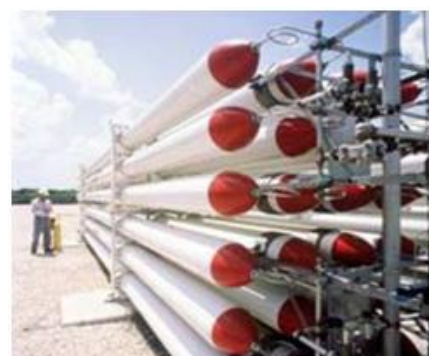
Εικόνα 1.4 Μεταφορά υδρογόνου σε σωλήνες υψηλής πίεσης (πηγή: U.S. Department of Energy Hydrogen Program)
