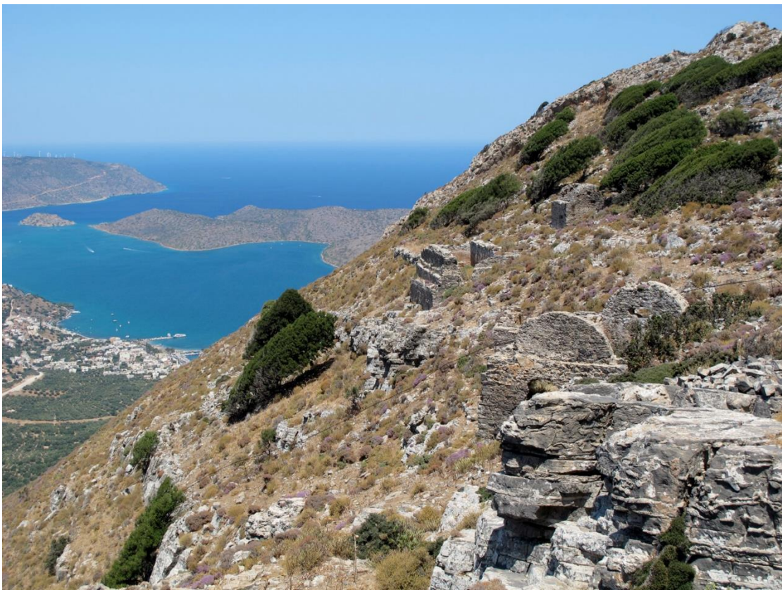
Εικόνα 21: Γενική άποψη του κεντρικού πλατώματος της Οζάς, με την εκκλησία του Τιμίου Σταυρού και τις υδατοδεξαμενές (πάνω). Οι υδατοδεξαμενές της βορειοδυτικής πλαγιάς της Οζάς (κάτω)
