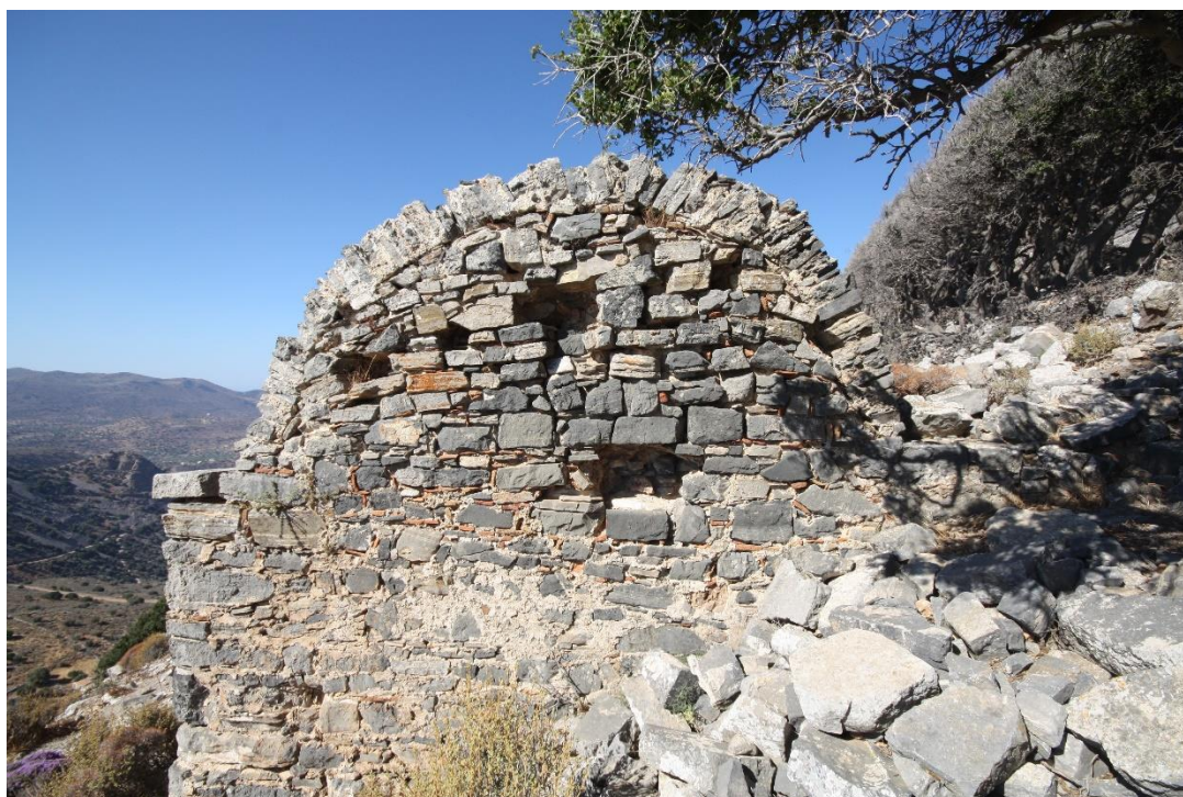
Εικόνα 22: Η δυτική όψη της δεξαμενής 07, όπου διακρίνεται η χρήση κεραμικής στην τοιχοποιία
