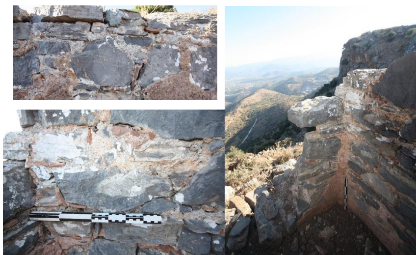
Εικόνα 25: Απόψεις της τοιχοποιίας της δεξαμενής 32, με χρήση κεραμικής στην αρμολόγηση των τοίχων
