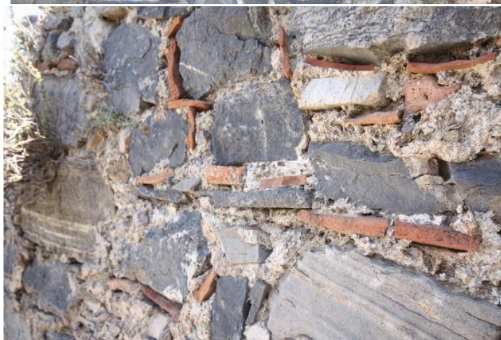
Εικόνα 23: Λεπτομέρειες από την τοιχοποιία της δεξαμενής 07
