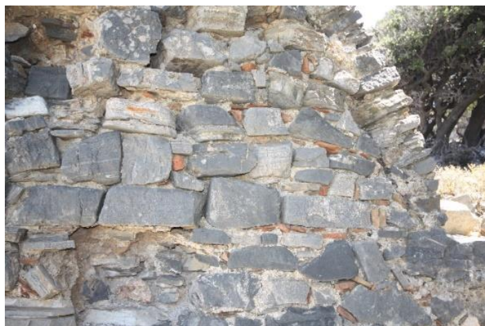
Εικόνα 22: Η δυτική όψη της δεξαμενής 07, όπου διακρίνεται η χρήση κεραμικής στην τοιχοποιία
