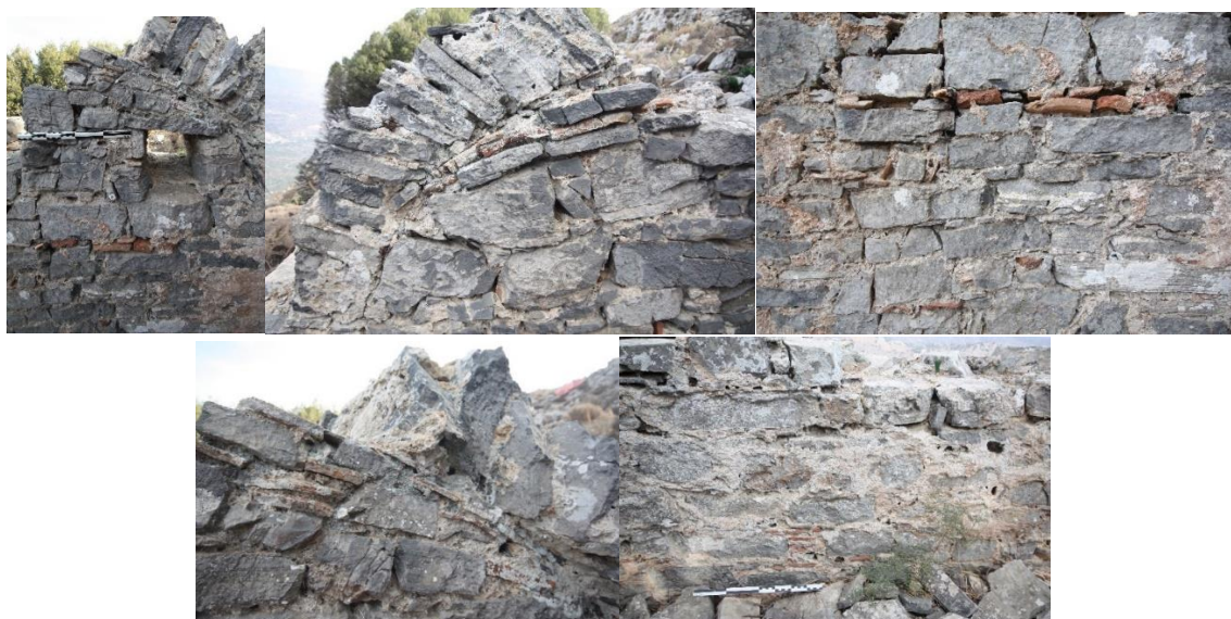
Εικόνα 24: Απόψεις της τοιχοποιίας της δεξαμενής 16, με χρήση κεραμικής στην τοιχοποιία
