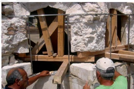
Εικ. 22. Τοποθέτηση νέων μεταλλικών πλαισίων παραθύρων.
